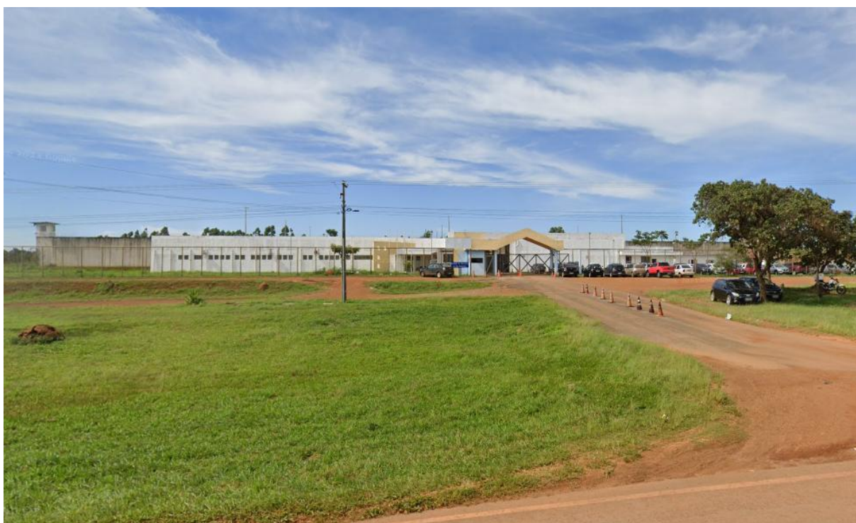
Figura 6 - Vista frontal da Unidade de Internação de São Sebastião (UISS)
