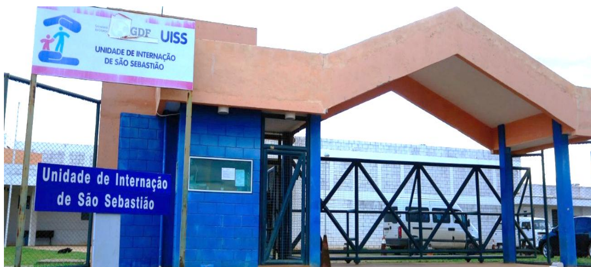
Figura 5 - Unidade de Internação de São Sebastião
