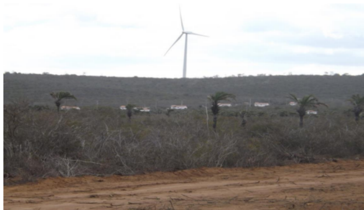
Figura 27 - Comunidade de Fundo de Pasto Fazenda Quina e o parque Sertão Energias Renováveis
