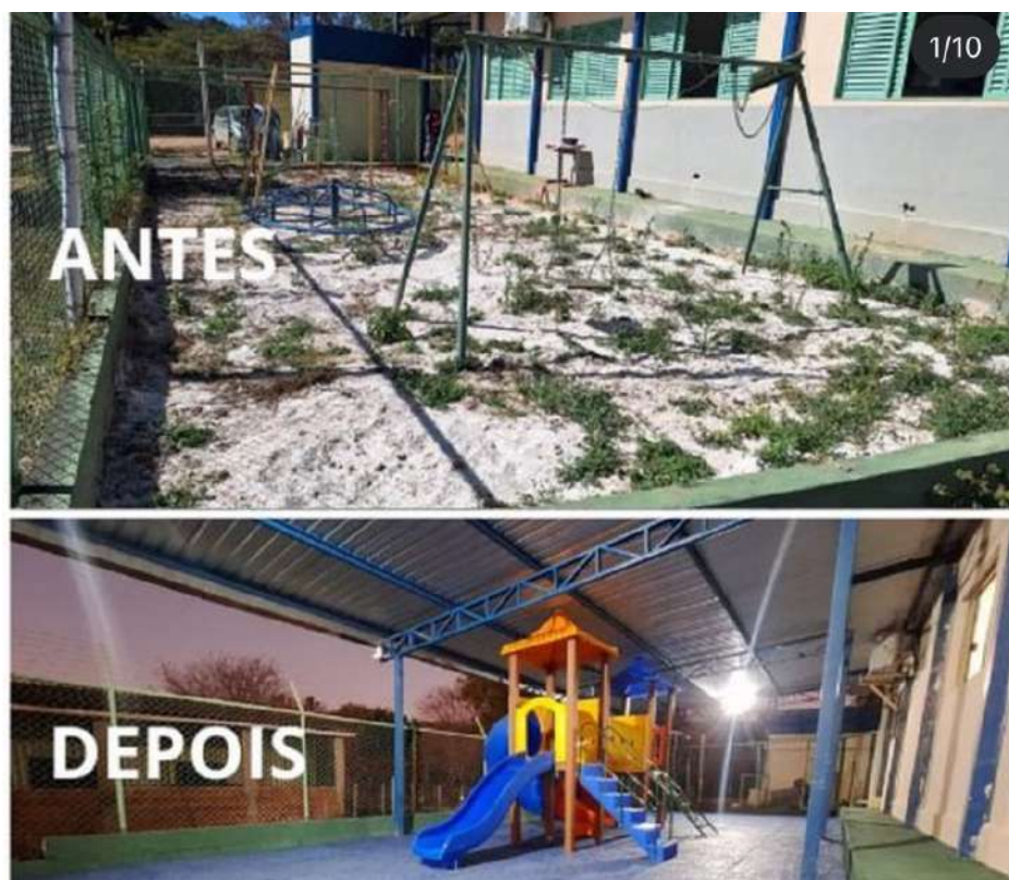
Figura 28: Reforma no parquinho infantil
