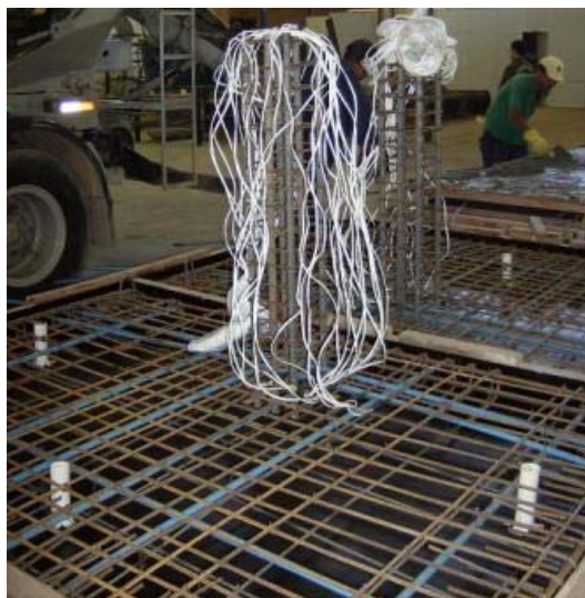
Figura 3.20 – Canos de PVC fixados nas fôrmas.
