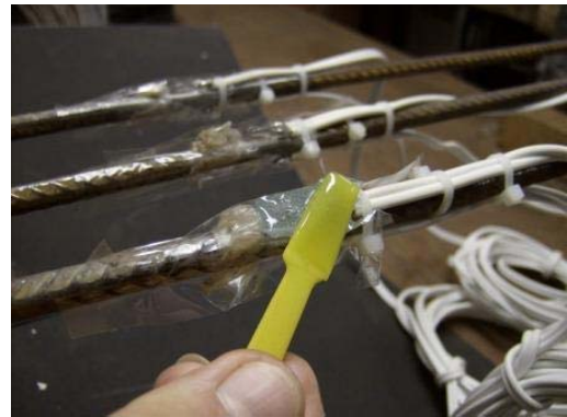
b) – Detalhe da proteção isolante com resina epóxi.
