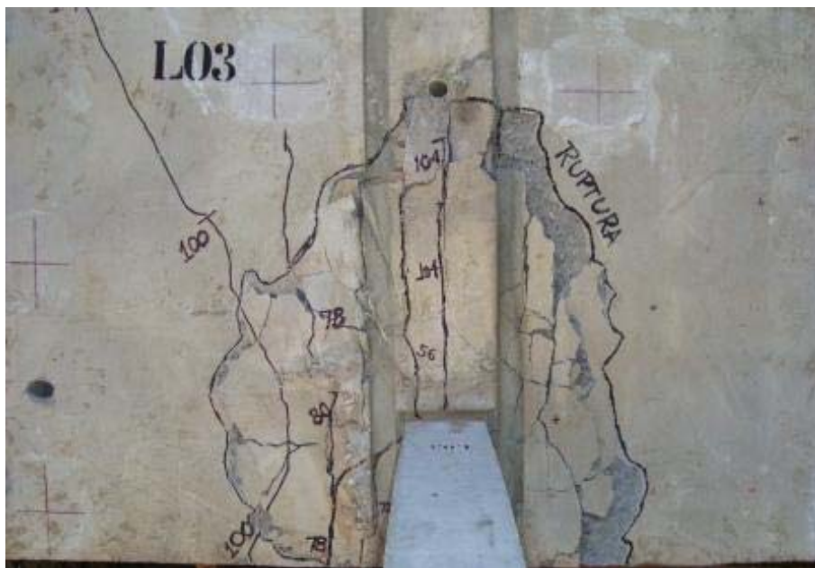
Figura 4.62 – Ruptura da laje do Modelo L03.
