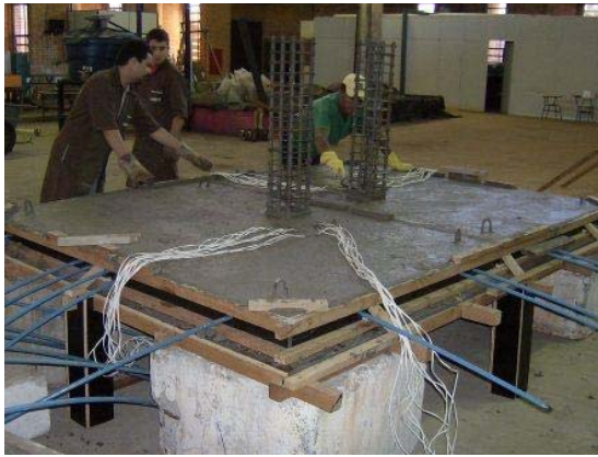
(a) – Acabamento das lajes
