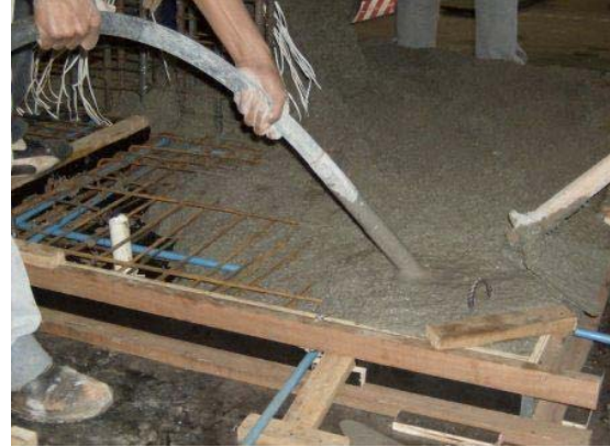
(b) – Concreto sendo adensado com vibradores de diferentes diâmetros
