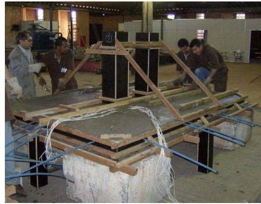
(b) – Colocação das formas superiores dos pilares
