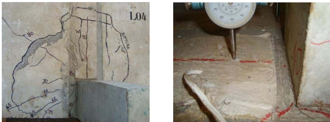
Figura 5.2 – Padrão de fissuração do modelo L04
