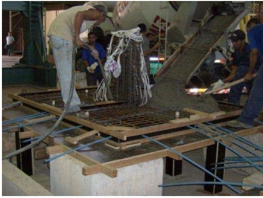
(a) – Concreto sendo lançado nas fôrmas diretamente do caminhão betoneira
