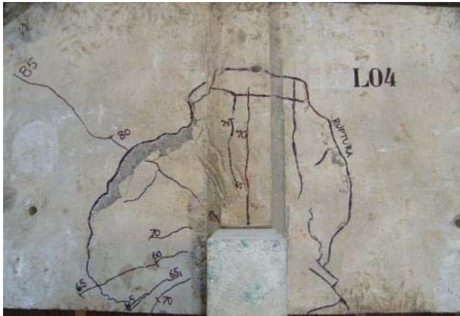
Figura 4.63 – Ruptura do da laje Modelo L04.
