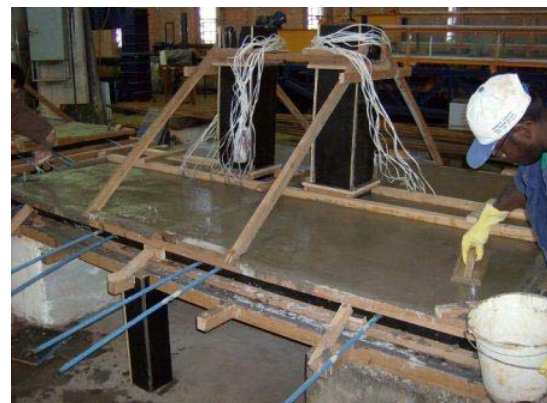
(d) – Acabamento na superfície das lajes.
