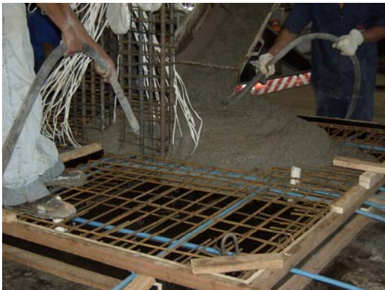
(a) – Utilização dos vibradores na concretagem
