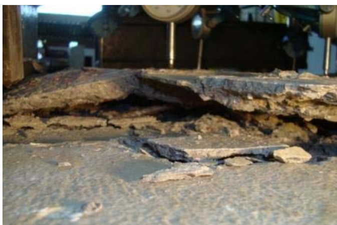
Figura 6.1 – Superfície da laje do modelo após a ruptura.
