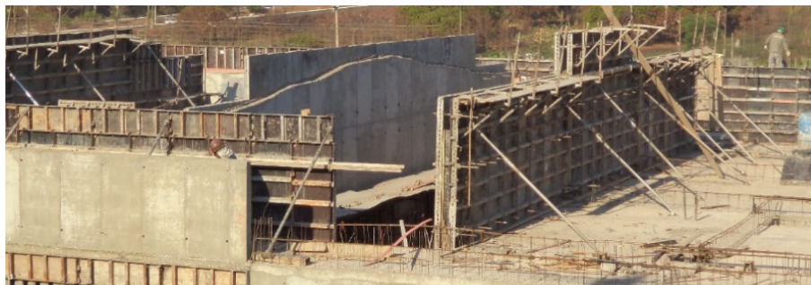
Figura 14 – Paredes de concreto moldado in loco do Presídio Colméia de Brasília
