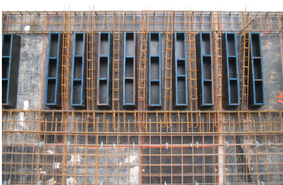
Figura 16 – Paredes de concreto moldado in loco do Presídio Feminino do Gama Fonte: Acervo da Empresa COMBRASEN – Companhia Brasileira de Soluções de Engenharia
