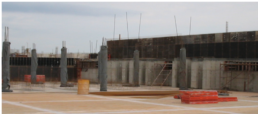
Figura 15 – Paredes de concreto moldado in loco do Presídio Feminino do Gama Fonte: Acervo da Empresa COMBRASEN – Companhia Brasileira de Soluções de Engenharia
