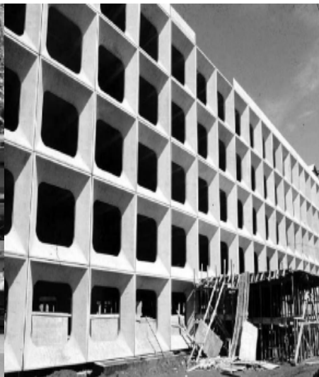
Figura 26 – Anexo dos Ministérios, Niemeyer. Fachada composta de peças pré-fabricadas acopladas a uma estrutura moldada in loco Fonte: www.niemeyer.org.br
