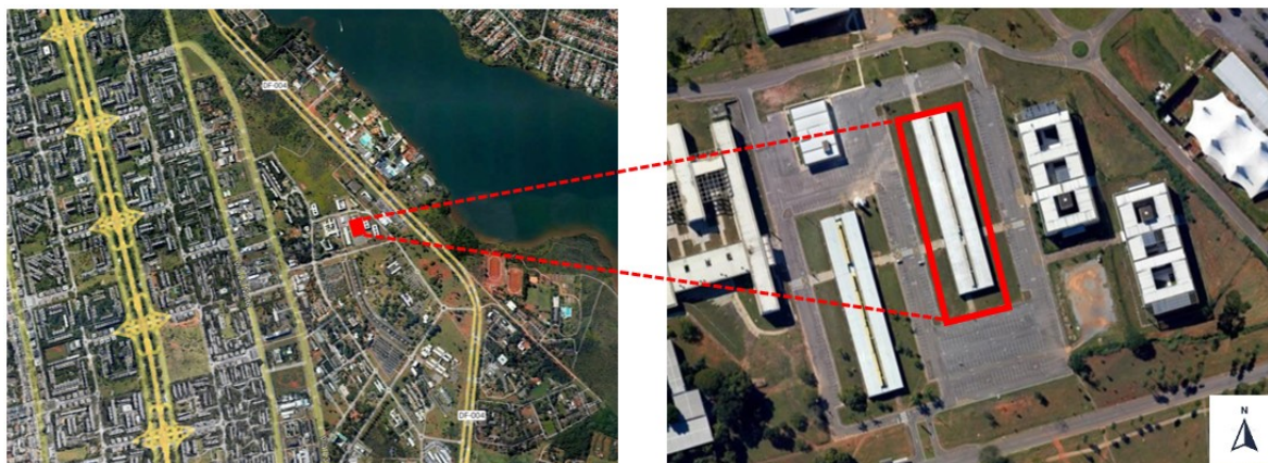
Figura 34: Localização do edifício – PJC.
