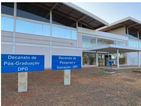
Figura 32: Vista geral do edifício – Fachada.
