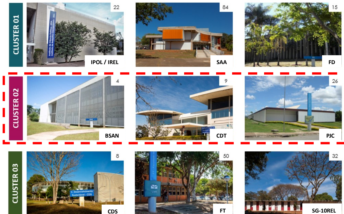
Figura 12: Fachadas dos edifícios selecionados.
