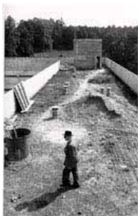
Fig. 144 - Convento de La Tourette – terraço
