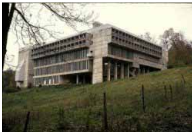
Fig. 145 – Convento de La Tourette – vista externa
