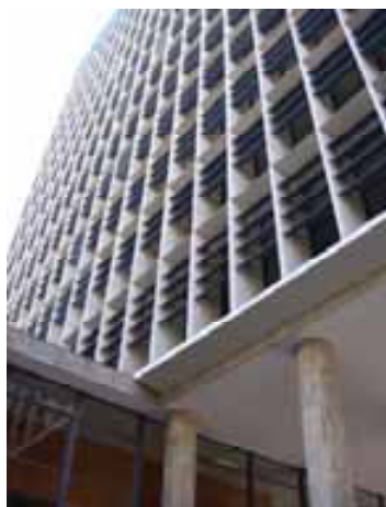
Fig. 99 e Fig. 100 – Detalhe brises
