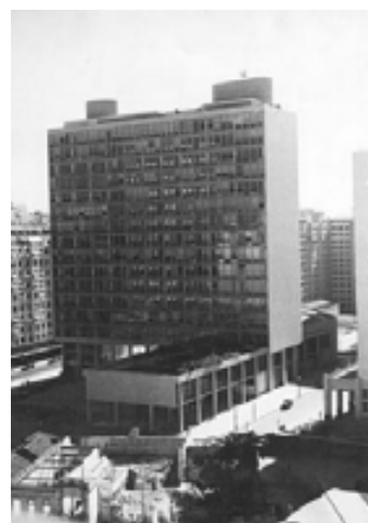
Fig. 119 – MES – fachada sul
