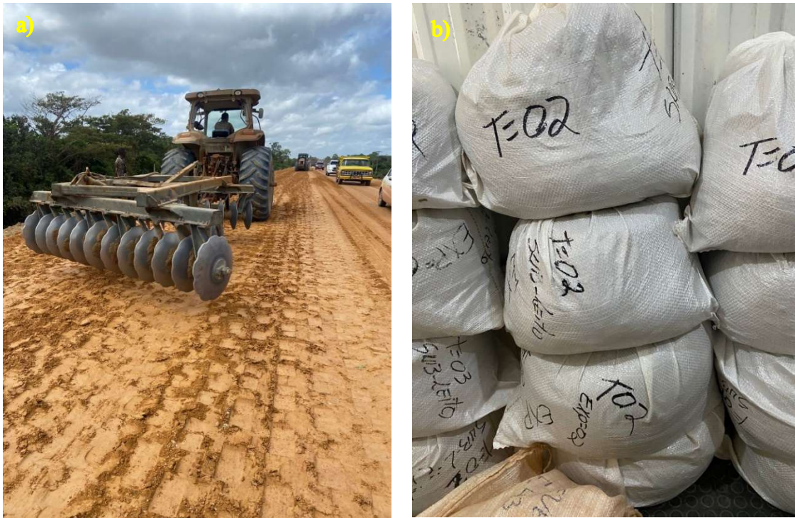
Figura 4.5. a) Trator com grade para homogeneização do material das camadas. b) Amostras embaladas com dupla proteção para evitar perda de material.
