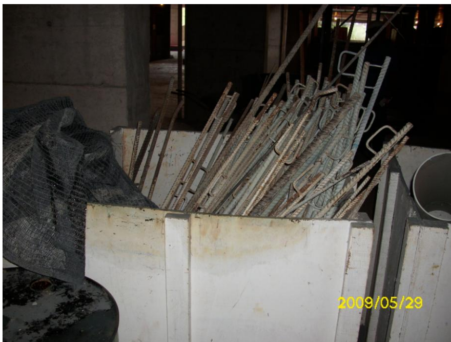
Foto 9: Baia de vergalhões e materiais metálicos no canteiro de obras.
