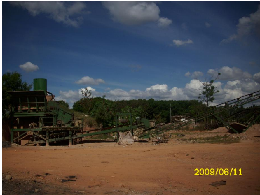
Foto 3: Vista geral da mini-usina de beneficiamento de Resíduos Sólidos da Construção e Demolição.
