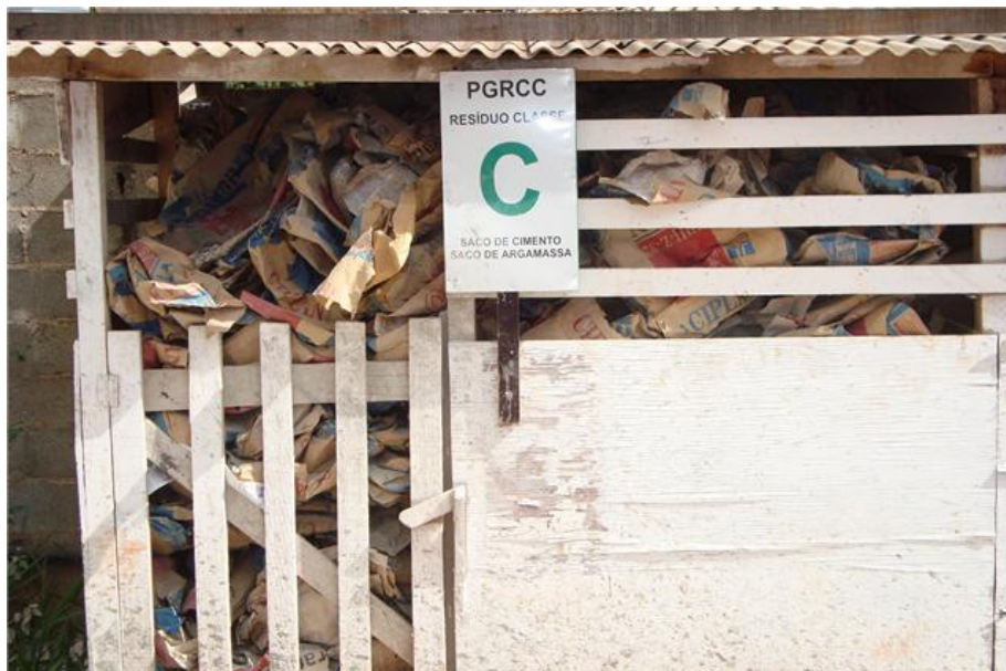
Foto 6: Espaço reservado aos Resíduos de Classe C (Sacos de Cimento e de Argamassa), proposto pelo Plano de Gerenciamento de Resíduos da Construção Civil efetuado em um dos canteiros de obra da EGP.
