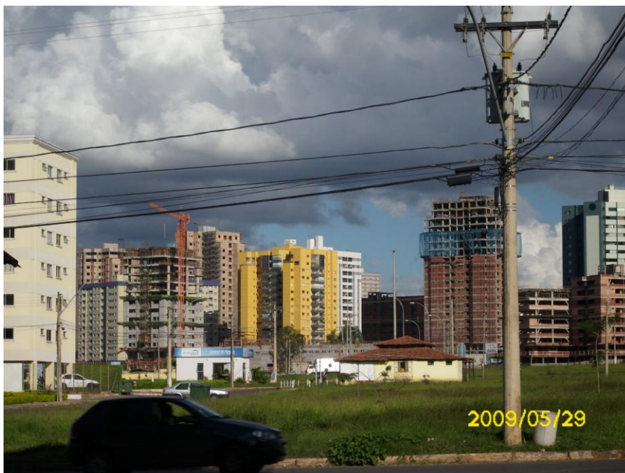
Foto 21: Ao fundo, vêem-se várias edificações em construção (canteiros de obras) em Águas Claras.
