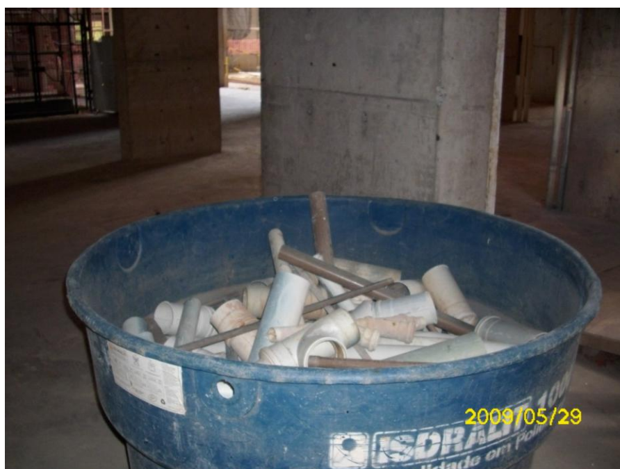
Foto 8: Baia de Tubos de PVC no canteiro de obras da EMP B.
