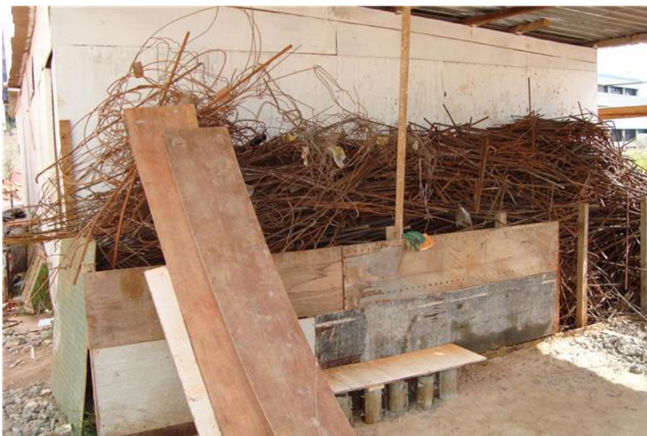
Foto 7: Espaço reservado aos Resíduos de vergalhões, ferro e materiais metálicos, proposto pelo Plano de Gerenciamento de Resíduos da Construção Civil executado em um dos canteiros de obras da EGP.
