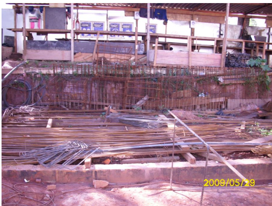
Foto 18: Depósito de ferro e vergalhões dentro do canteiro de obra da EMP A.
