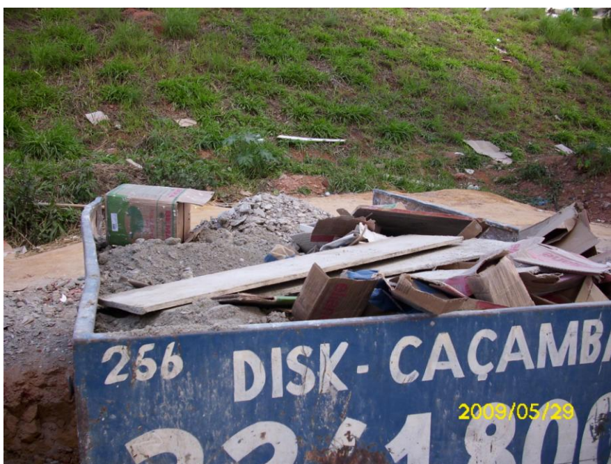
Foto 12: Containers contendo entulhos diversos (lixo comum e resíduos de Classe A e B misturados).
