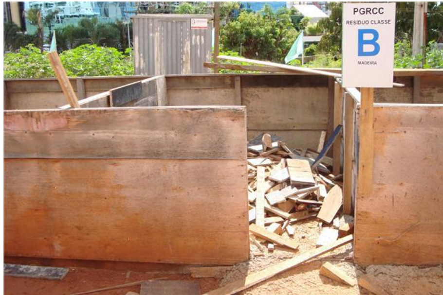
Foto 5: Espaço reservado aos Resíduos de Classe B (Madeira), proposto pelo Plano de Gerenciamento de Resíduos da Construção Civil realizado em uma das obras da EGP.
