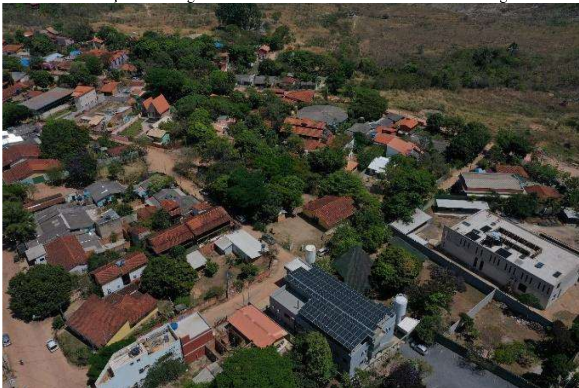
Ilustração 24: Imagem aérea do centro urbano do Distrito de São Jorge.
