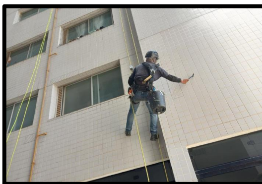
Figura 9 – Ensaio de percussão na inspeção.
