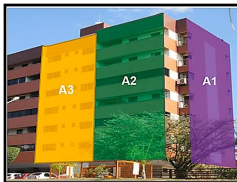
Figura 13 – Subdivisão das amostras da fachada (Bauer e Souza, 2022).
