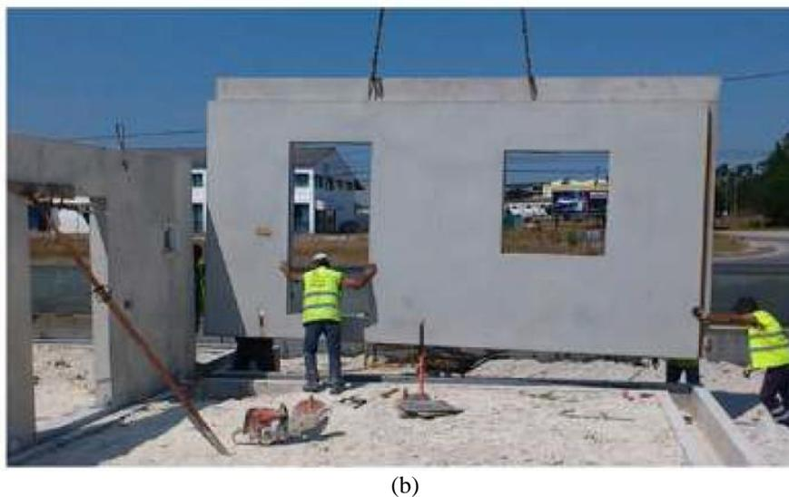
Figura 2 – Painéis Sanduíche: a) painel em produção e esquema do posicionamento do conector PERFOFRP no painel (dimensões em mm); b) painel pré-fabricado içado na fase de construção. Adaptado de Lameiras *et al.* (2021)
