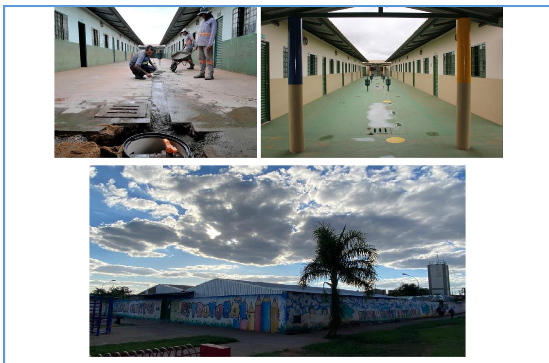
Imagem 4 - Reforma e instalação de filtragem do gás metano
