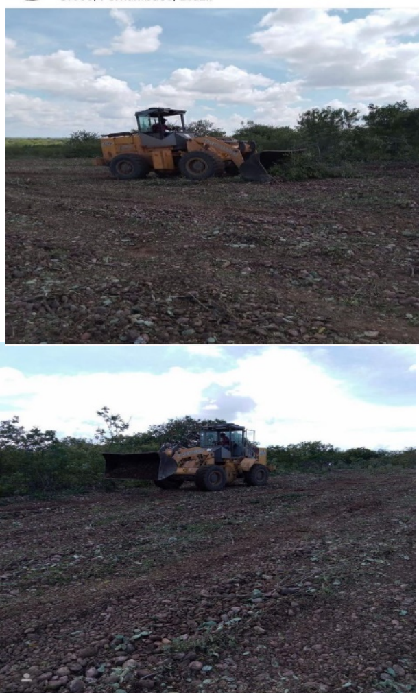
Figura 21: construção da Escola Estadual Quilombola na comunidade de Caatinguinha
