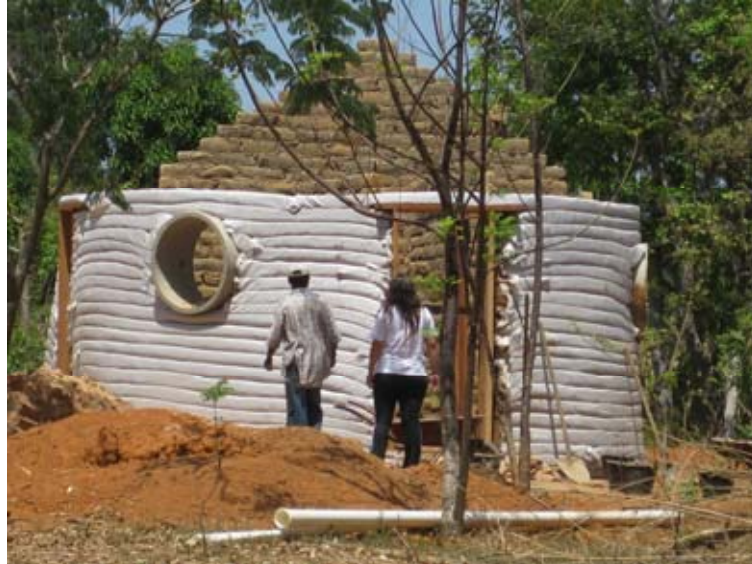
Figura 31 - Casa do Mel em constru o
