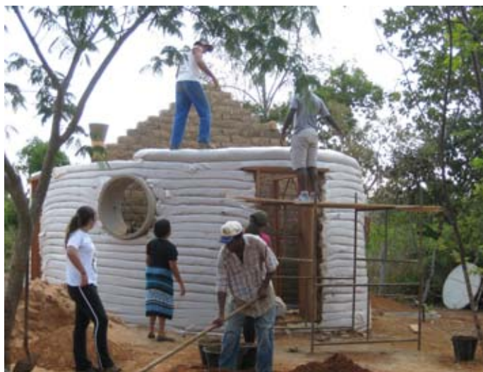
Figura 33 - Mutirão para a construção
