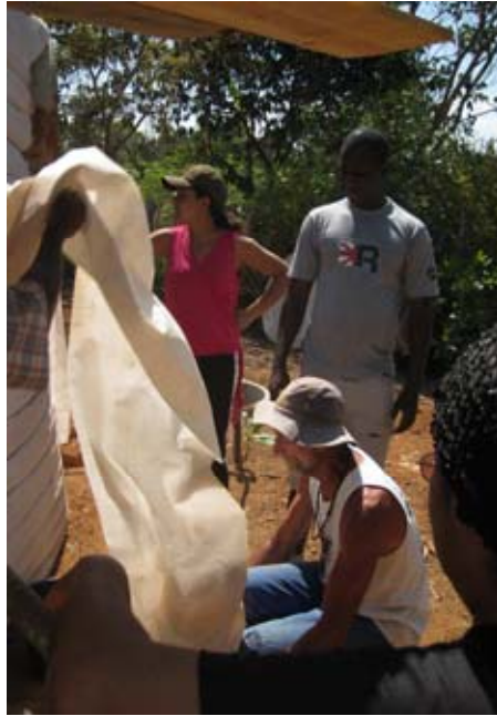
Figura 32 – Técnica de Superadobe
