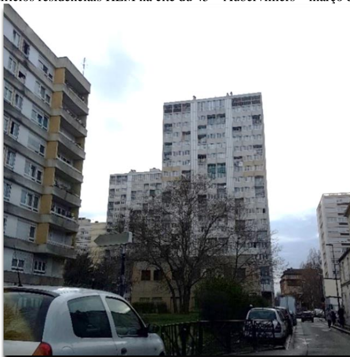
Figura 28 – Edifícios residenciais HLM na cité du 45 – Aubervilliers – março de 2020
