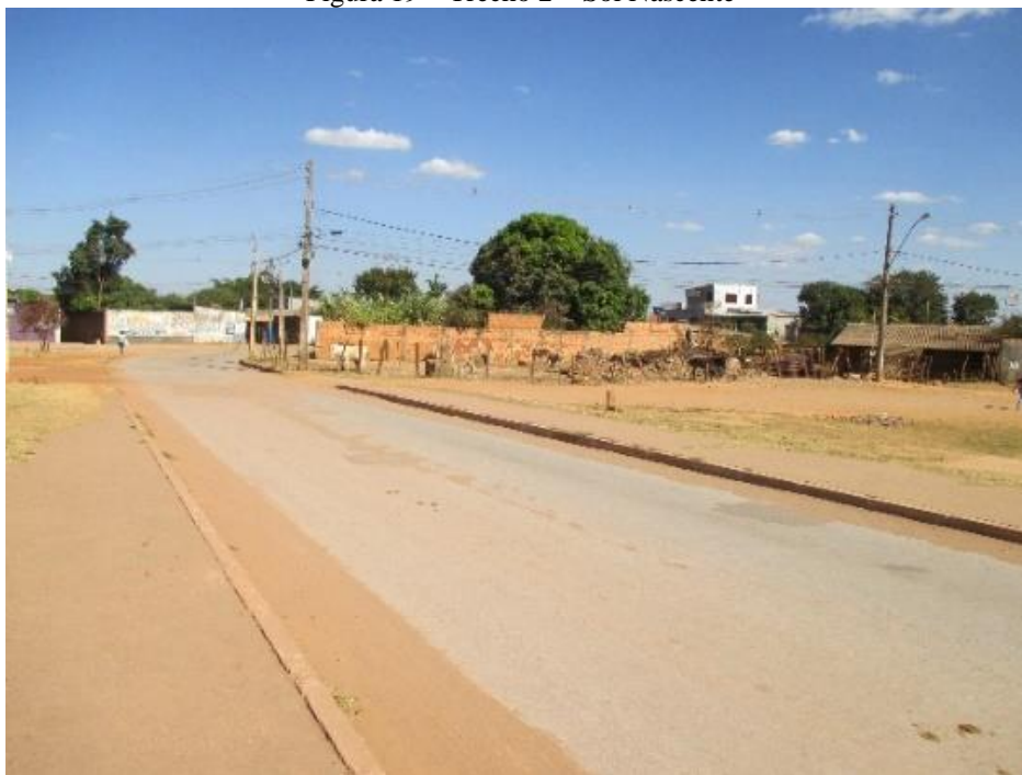
Figura 19 – Trecho 2 – Sol Nascente
