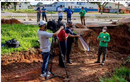
Figura 145 – Erosão, Q 10/11/Parque dos Jequitibás
