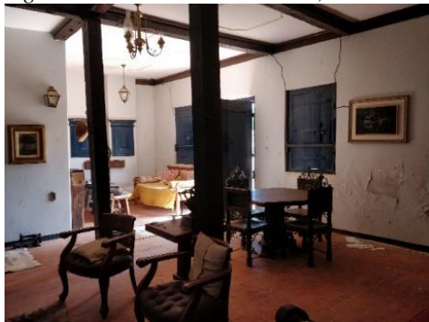
Figura 91 – Interior do Casarão, chácara 24
