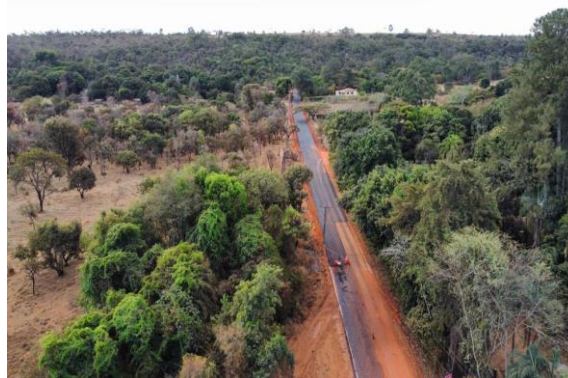
Figura 111 – Obra na subida do Parque Jequitibás
