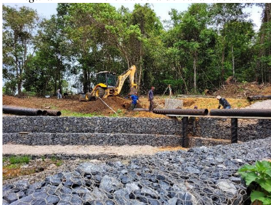
Figura 112 – Início da obra do canal tubulado
