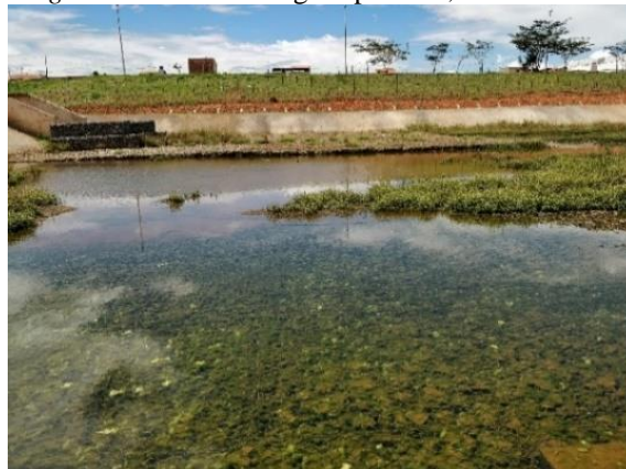
Figura 28 – Bacia de águas pluviais, Sobradinho 2
