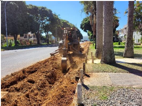
Figura 164 – Início das obras das novas calçadas
