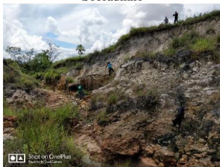
Figura 37 – Erosão na cabeceira do ribeirão Sobradinho
