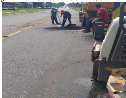
Figura 148 – Conserto do asfalto, Sobradinho
