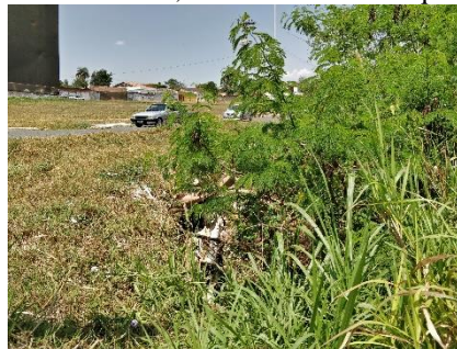
Figura 27 – Erosão, Avenida Contorno/quadra 13
