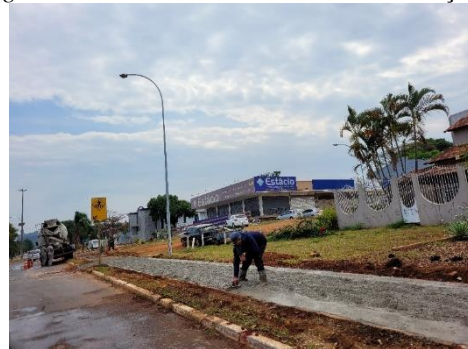
Figura 165 – Início das obras das novas calçadas
