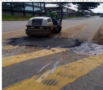
Figura 149 – Conserto do asfalto, Sobradinho
