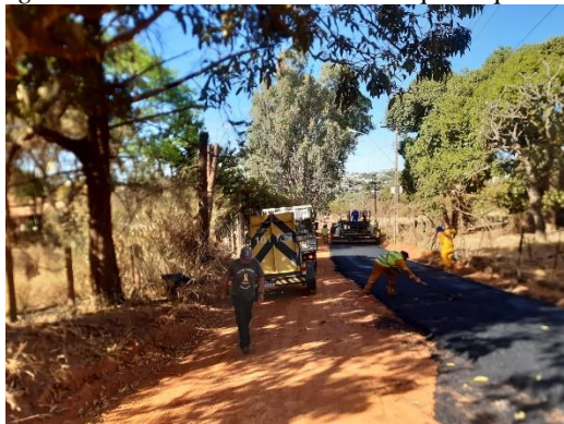
Figura 110 – Obra na subida do Parque Jequitibás
