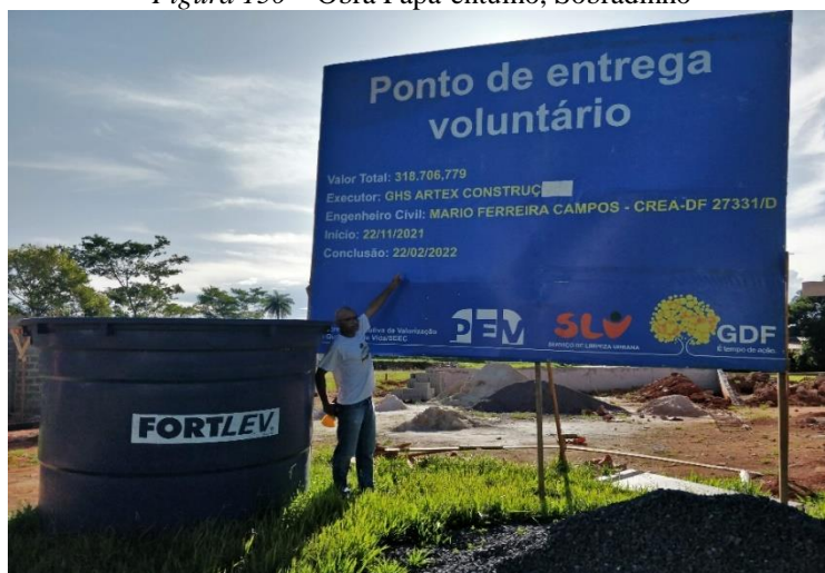
Figura 150 – Obra Papa-entulho, Sobradinho
