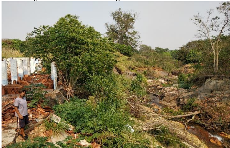
Figura 1 – Trecho da barragem do ribeirão Sobradinho
