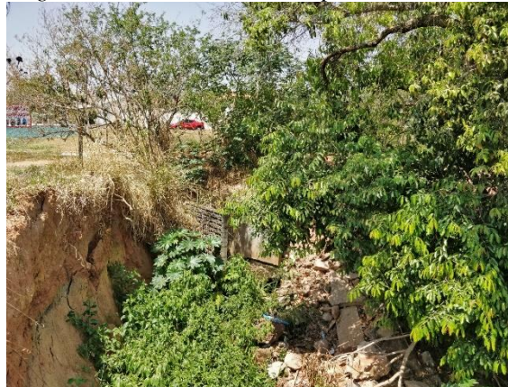
Figura 25 – Avenida Contorno próximo da erosão
