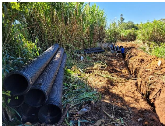
Figura 113 – Início da obra do canal tubulado
