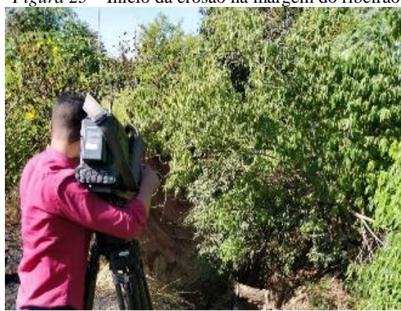
Figura 23 – Início da erosão na margem do ribeirão
