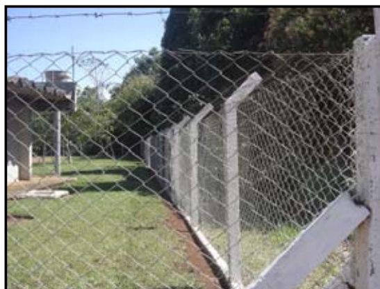
Figura 14. Reservatório Apoiado da CAESB, mostrando sua extensão.
