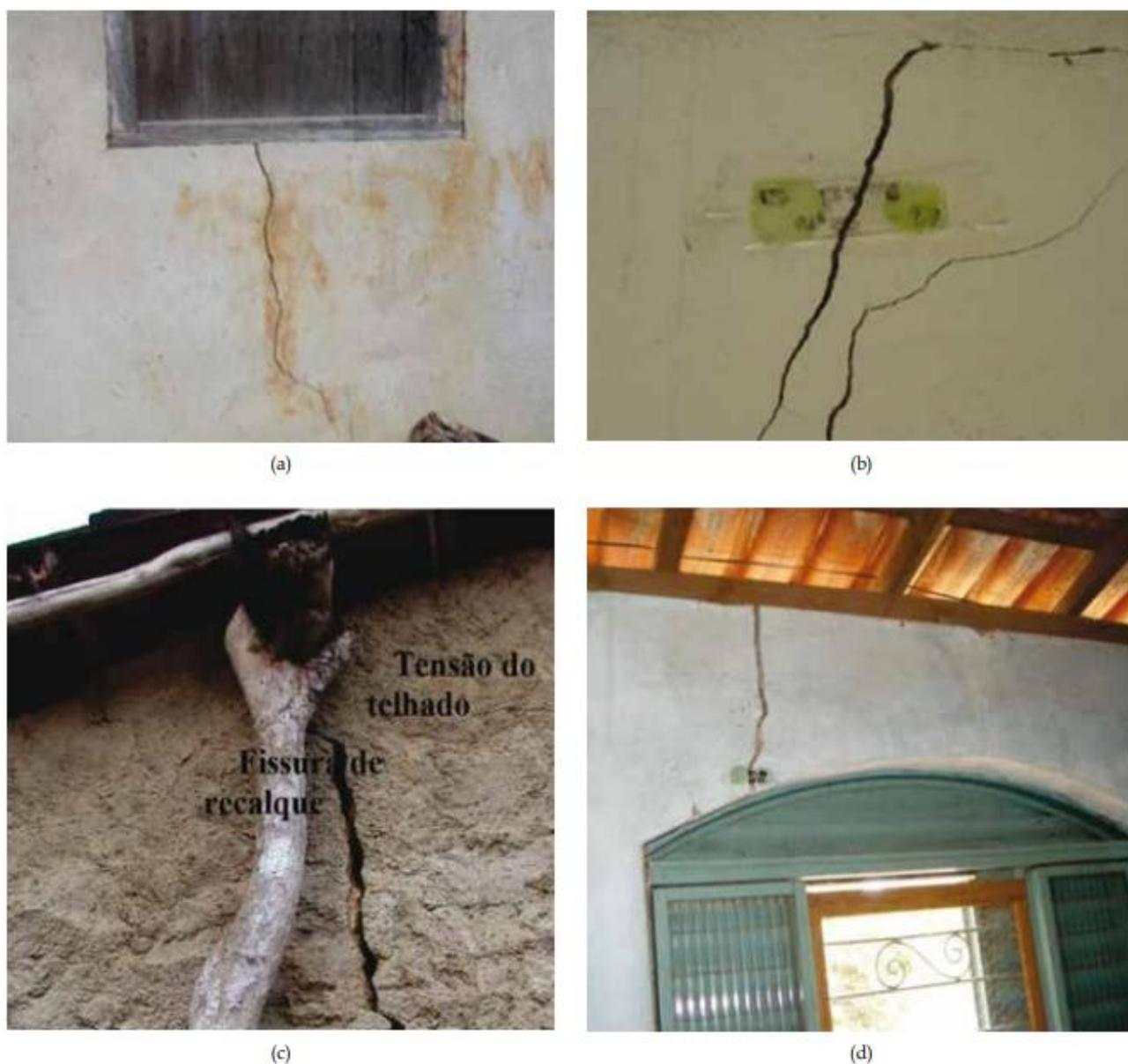
**Figura 3. 4.** a e b. Patologias geotécnicas em residências margeando a UHE de Peixe Angical/TO não vinculadas à sobrelevação do NF (CDT/UnB, 2008a); c e d: patologias em edificações em Pereira Barreto, SP causadas pela elevação do nível do nível freático (Vilar & Rodrigues, 2011).
