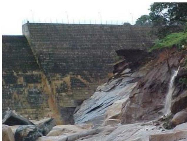
Figura 2.6 – Ruptura da barragem, vista de jusante (Kanji, 2004)
