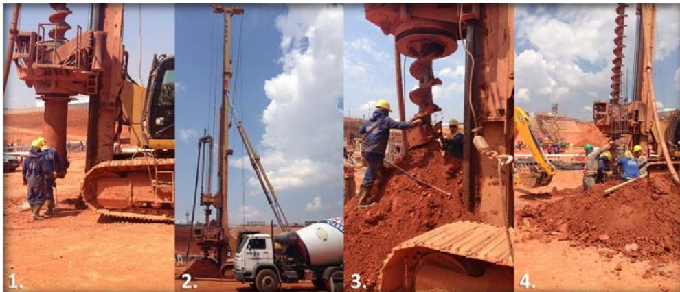
**Figura 2.1** - Etapas dos procedimentos executivos de uma estaca hélice contínua
