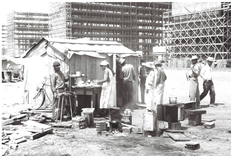
Figura 66: Canteiro de obras, 1966.
