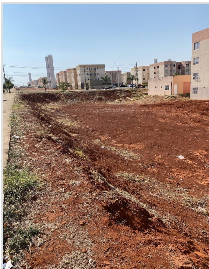
Fotografia 24: Acelerado processo erosivos pela falta de arborização, por exemplo. K.M. (2020)
