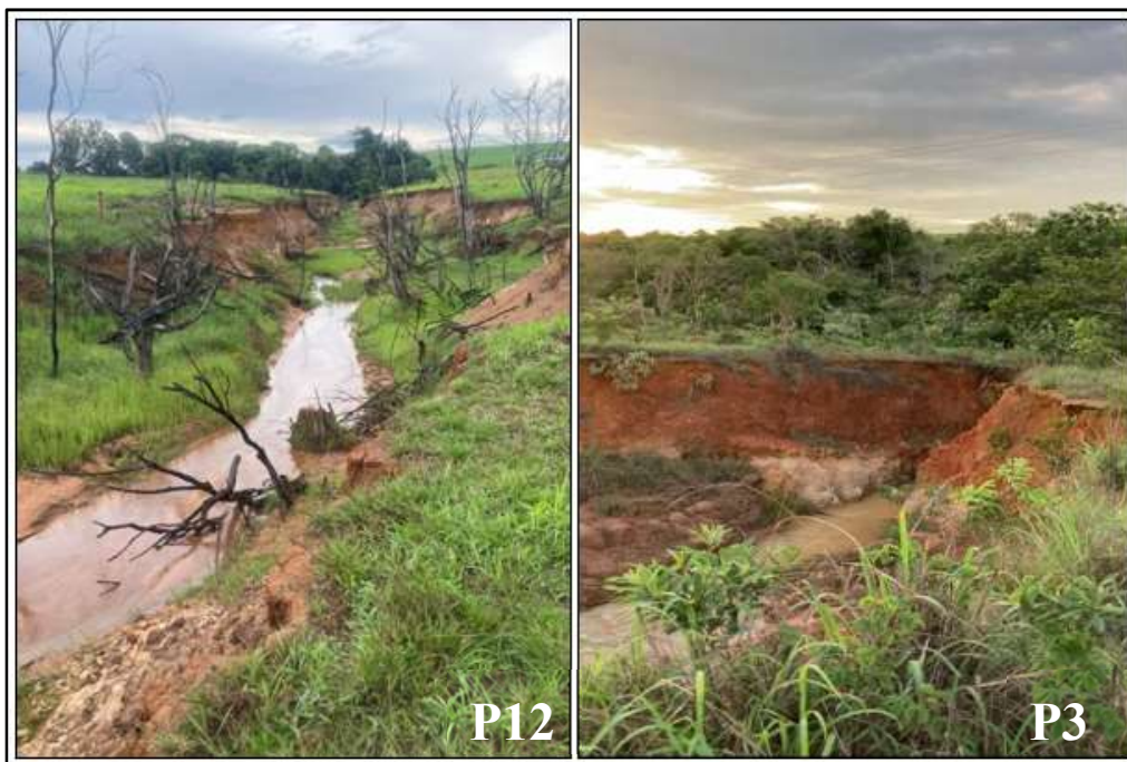
Figura 2.4: Registro de erosões na borda imediata do reservatório da UHE Batalha.
