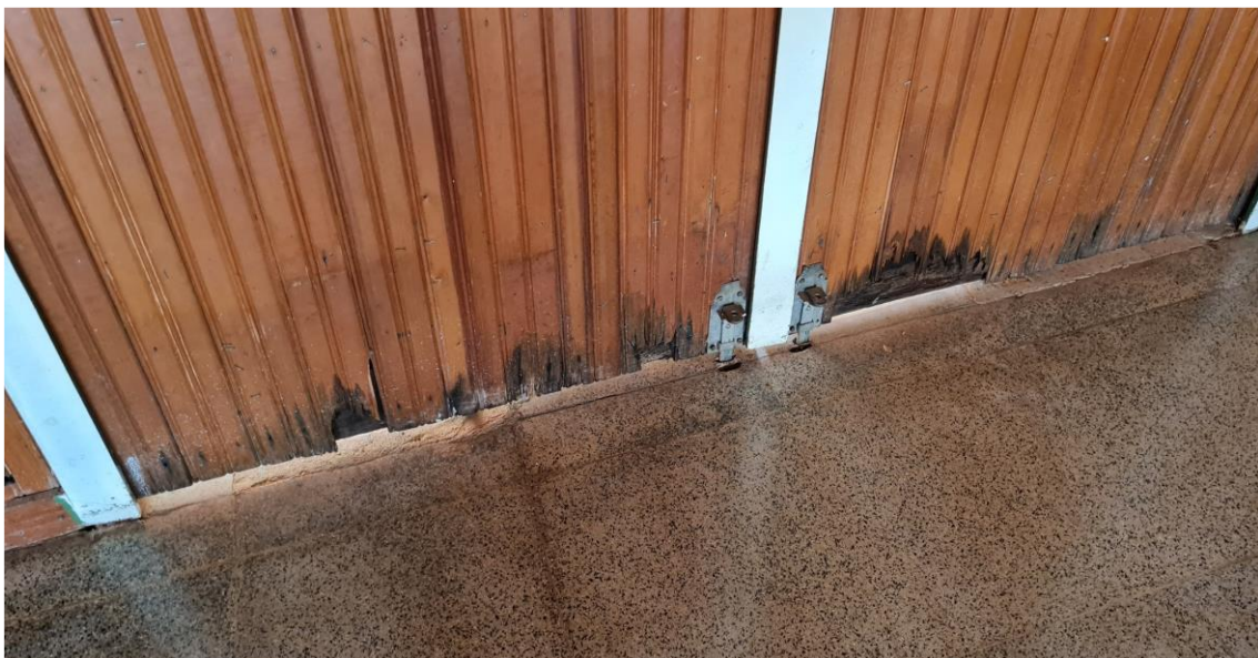
Figura 37: Lambri de Madeira afetado por cupins (FNDE/UNB, 2021)
