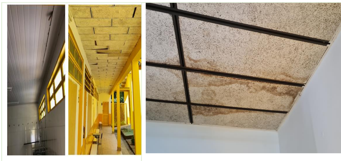
Figura 48: Forro tipo pacote e PVC (FNDE, 2021)
