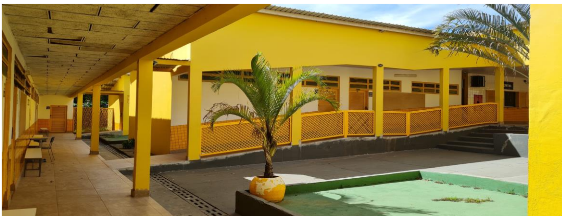
Figura 34: Pintura área interna (FNDE, 2021)
