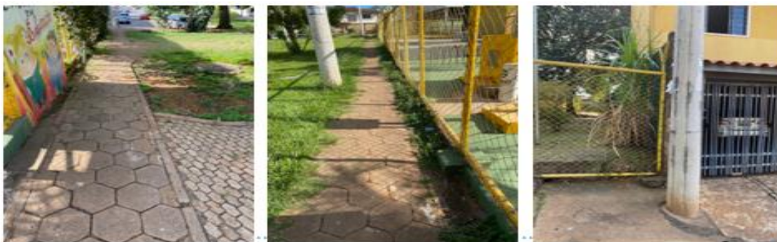
Figura 51: Passeios área externa de acesso a CEF-Metropolitana (FNDE/UNB, 2021)
