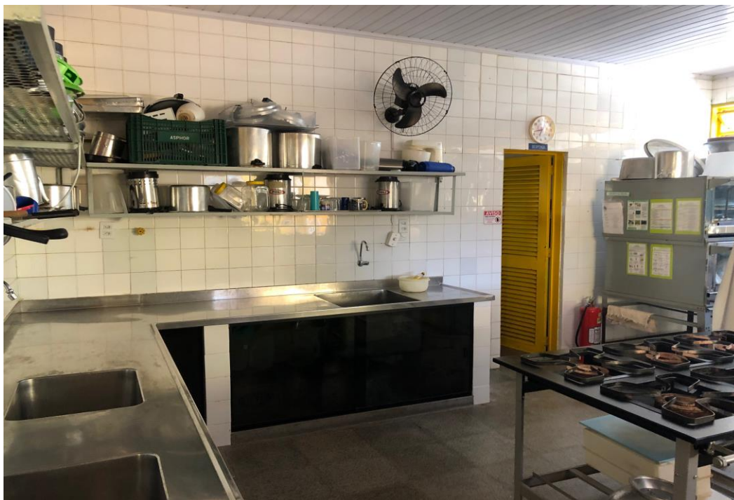
Figura 42: Cantina - Revestimento Cerâmico (FNDE, 2021)
