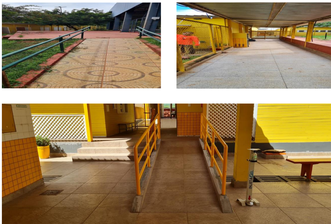
Figura 53: Rampas de acessibilidade (FNDE/UNB, 2021)
