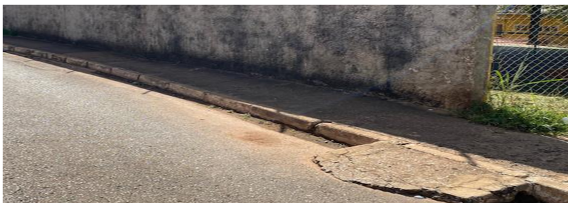
Figura 52: Passeio externo junto ao muro (FNDE/UNB, 2021)
