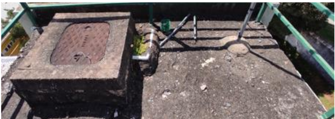
Figura 33: Reservatório da CEF-Metropolitana (FNDE/UNB, 2021)
