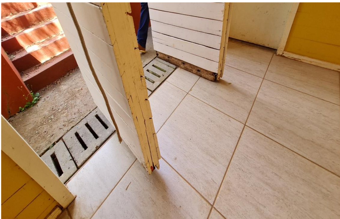
Figura 44: Portas fora de padrão para rotas de fuga e PNE (FNDE, 2021)
