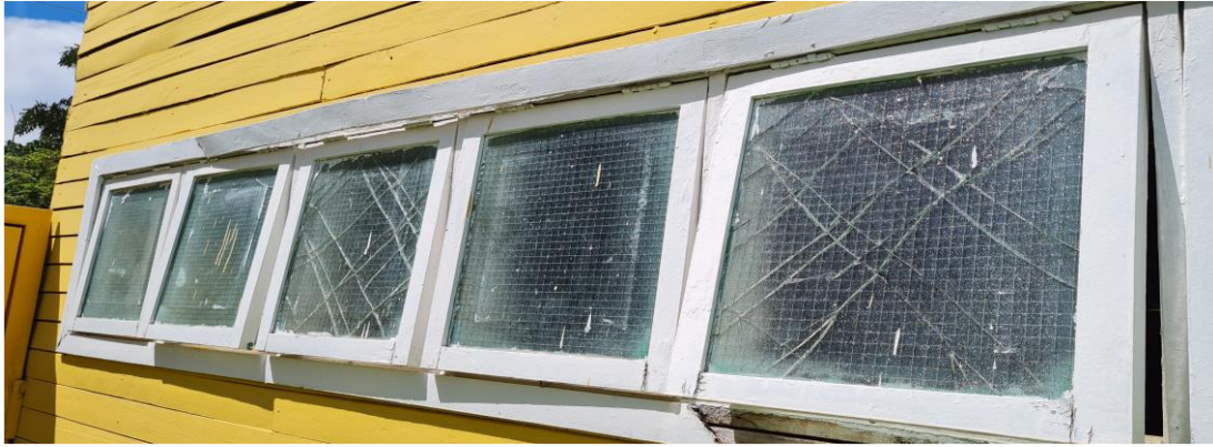
Figura 38: Esquadrias com vidro aramado (FNDE, 2021)
