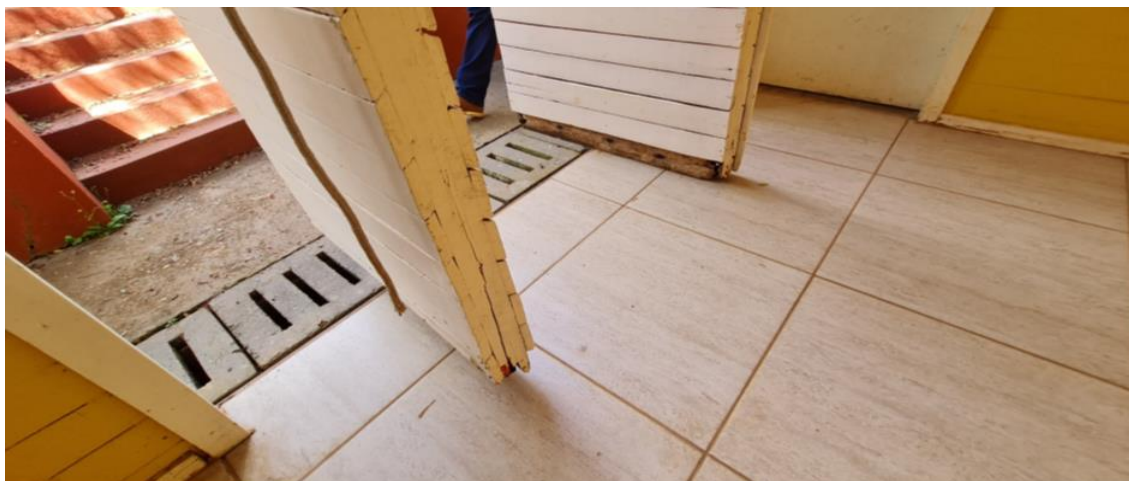
Figura 41: Portas em pivô central (FNDE/UNB, 2021)
