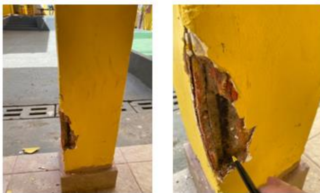
Figura 56: Pilar com despassivação (FNDE/UNB, 2021)
