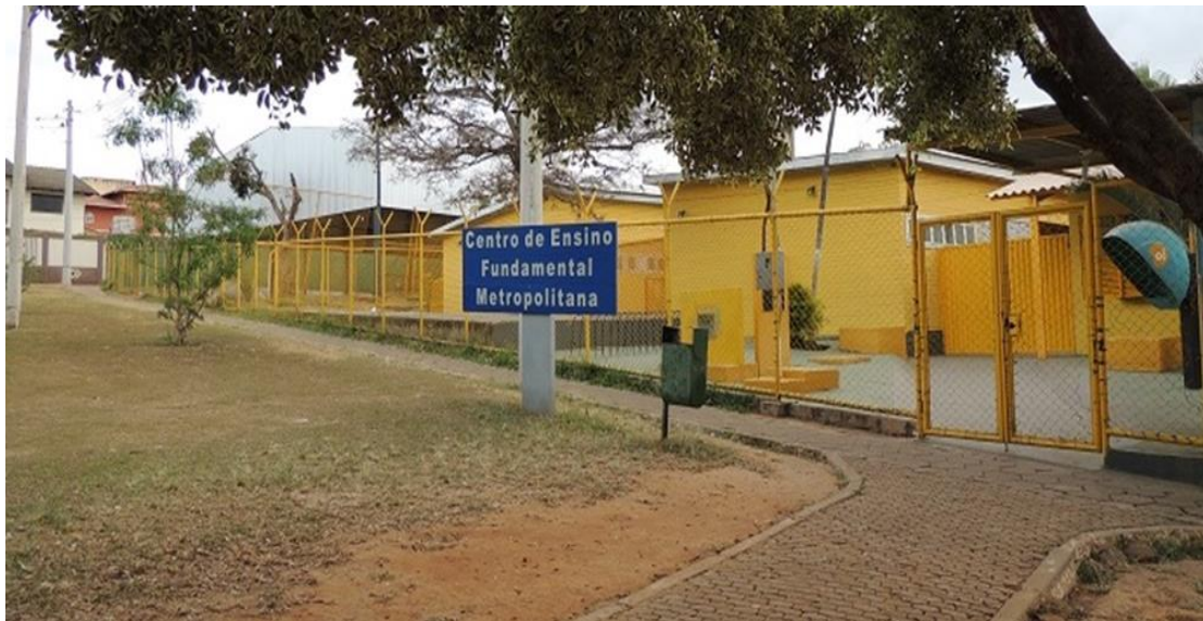
Figura 4: CEF Metropolitana. Vista da Fachada Principal (FERREIRA; GUIMARÃES; GALIMI, 2021)
