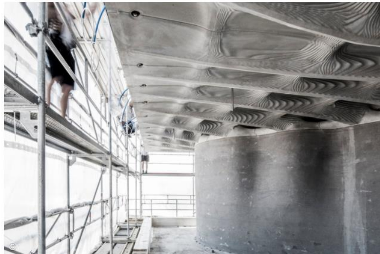
Figura 20 – Edificação com elementos impressos – ETH de Zurique
