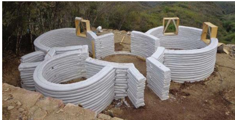
Figura 2 – Edificação de superadobe
