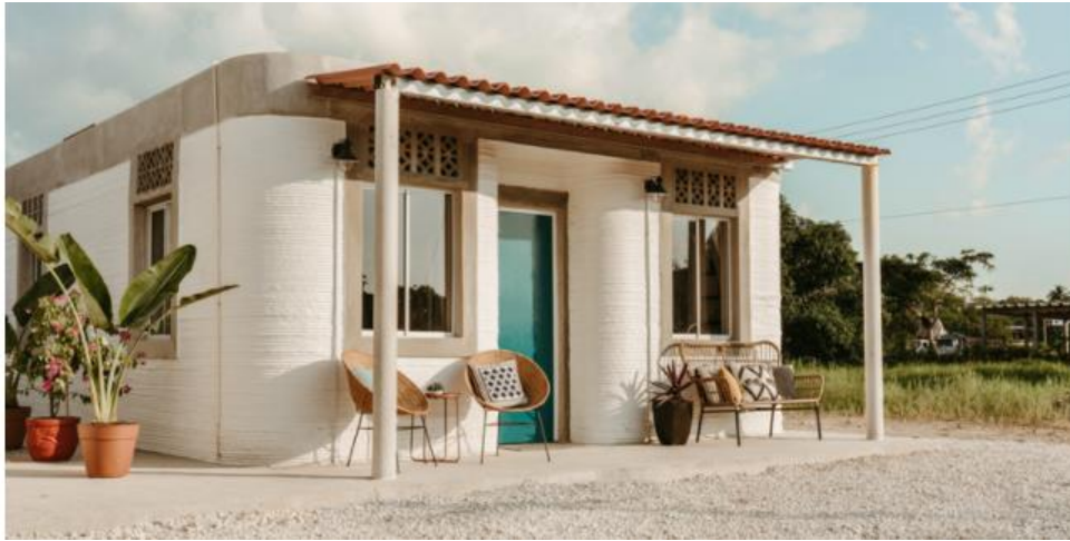
Figura 23 – Apis Cor. Conjunto de casas Impressas
