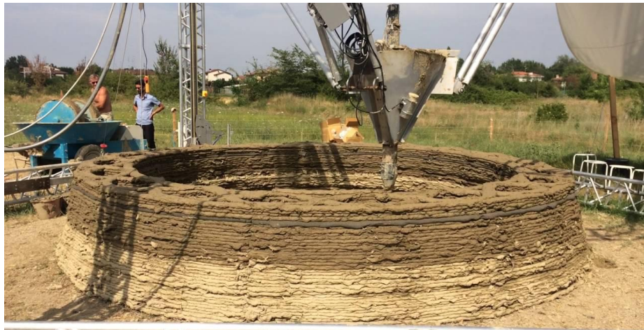
Figura 46 – Camadas com ondulações e marolas. Impressora de barro, 3D Wasp, Itália
