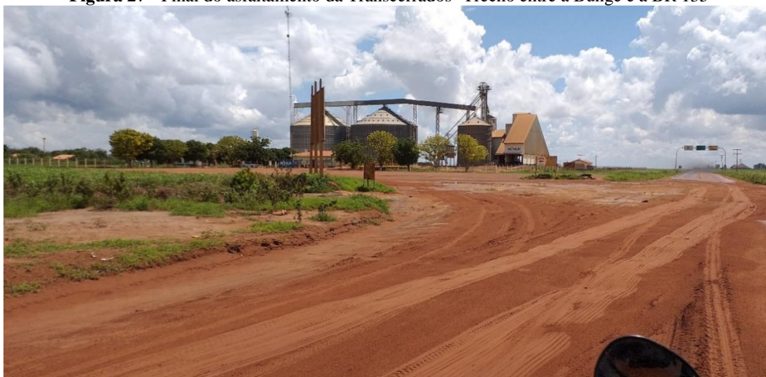
Figura 27 - Final do asfaltamento da Transcerrados- Trecho entre a Bunge e a BR 135
