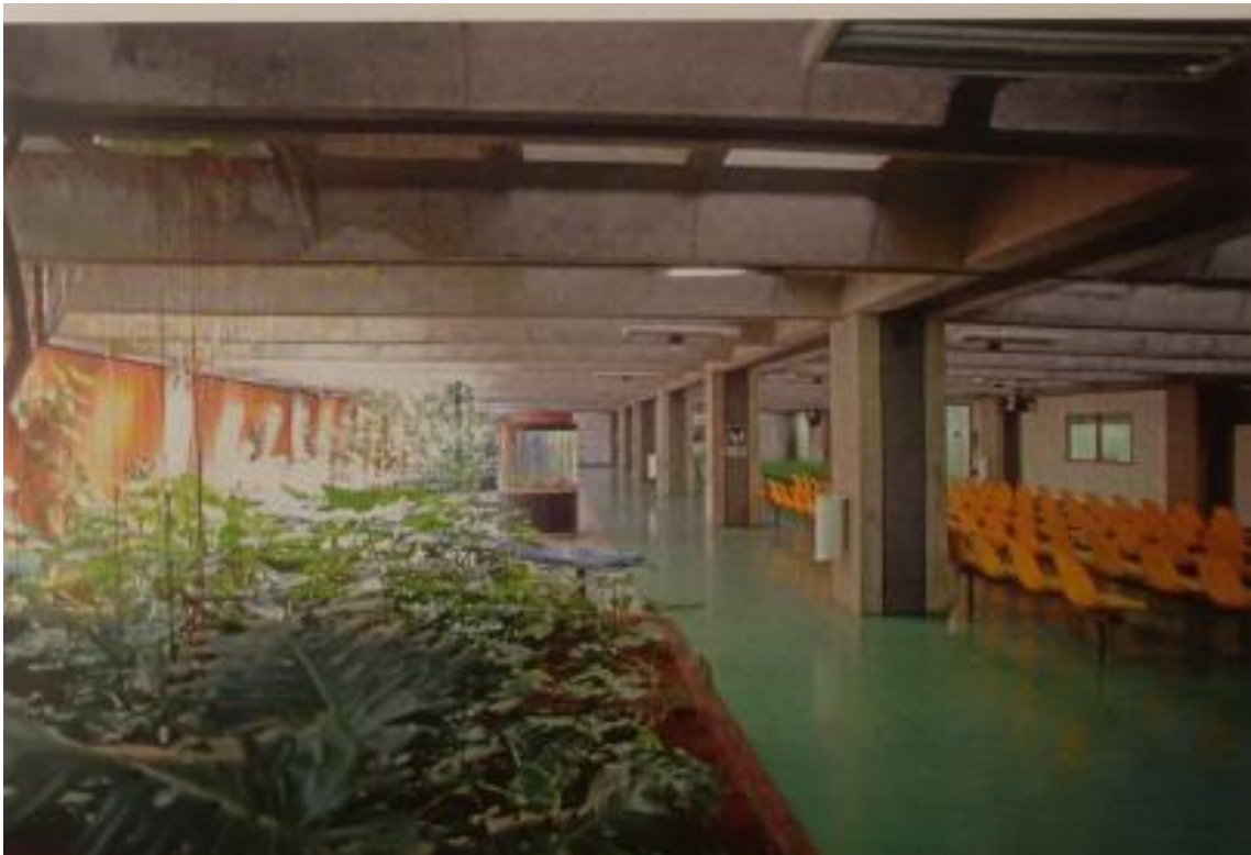
Imagem 25 – Conforto ambiental, jardim da recepção do ambulatório. Data da foto: Desconhecido. Fonte: LIMA, 2012.
