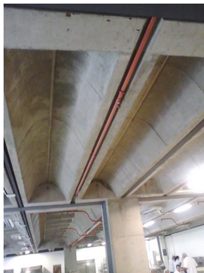
Imagem 32 – Sistema construtivo, nichos das vigas-calha
