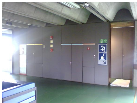
Imagem 30 – Sistema construtivo, proteções removíveis junto as descidas de instalações nas torres de circulações verticais.
