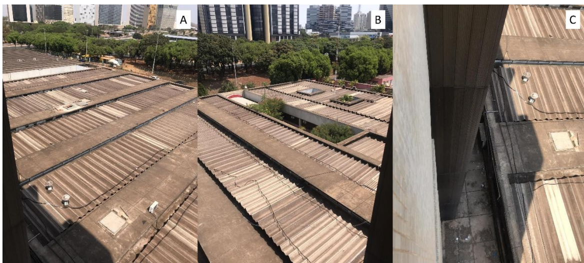
Imagem 64 – Estado de conservação coberturas Autor: Alyria Argôlo Donegá. Data da foto: 22/09/2019.
