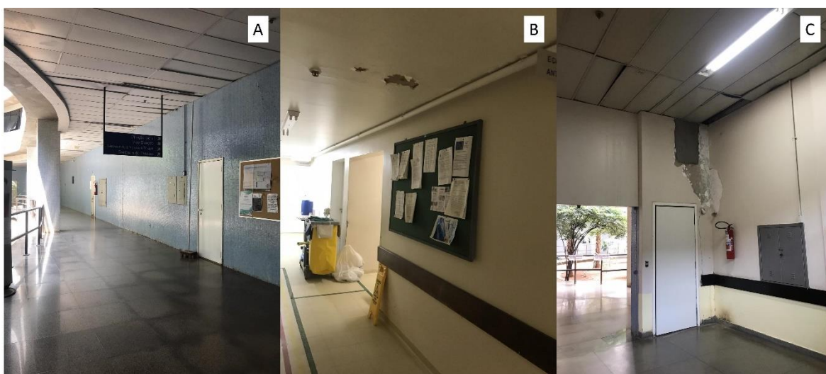
Imagem 59 – Estado de conservação forros Autor: Alyria Argôlo Donegá. Data da foto: 22/09/2019.
