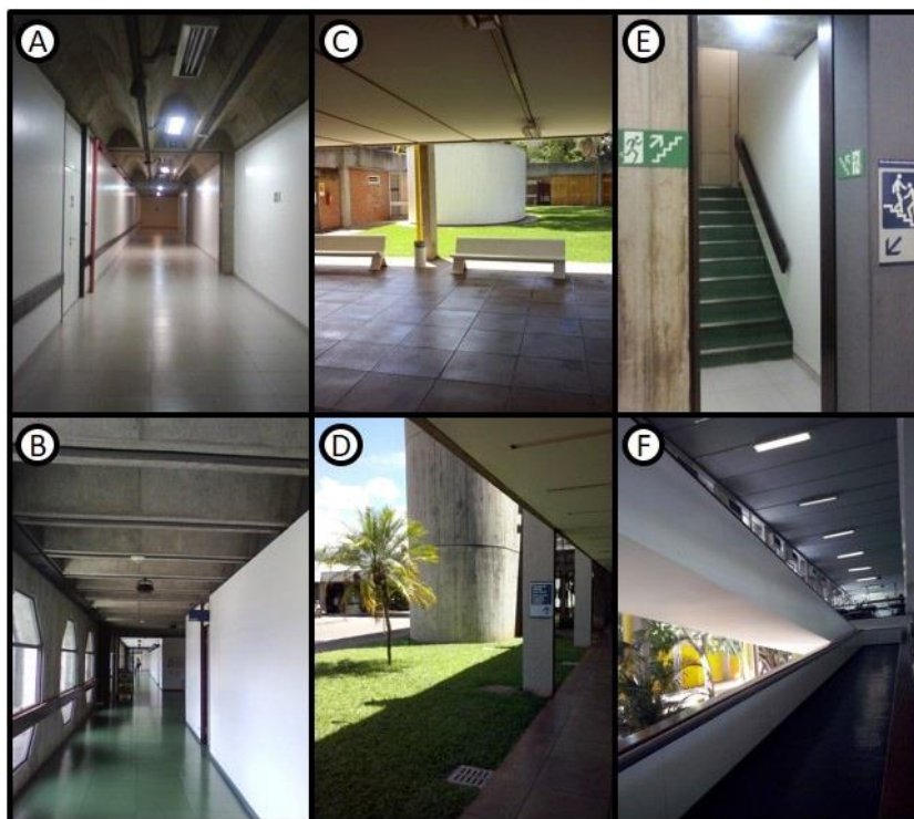
Imagem 35 – Composição plástica – em (A) circulação técnica 2º subsolo do complexo principal, (B) circulação geral 1º pavimento do complexo principal, (C) pátio externo Sarinha bloco A, (D) circulação externa Sarinha bloco A, (E) escadas do complexo principal e (F) rampa Sarinha bloco A.
