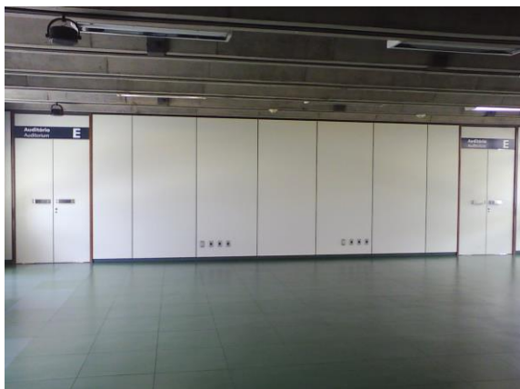
Imagem 29 – Sistema construtivo, paredes removíveis.
