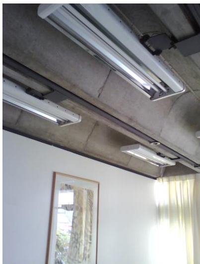
Imagem 31 – Sistema construtivo, nichos das vigas-calha
