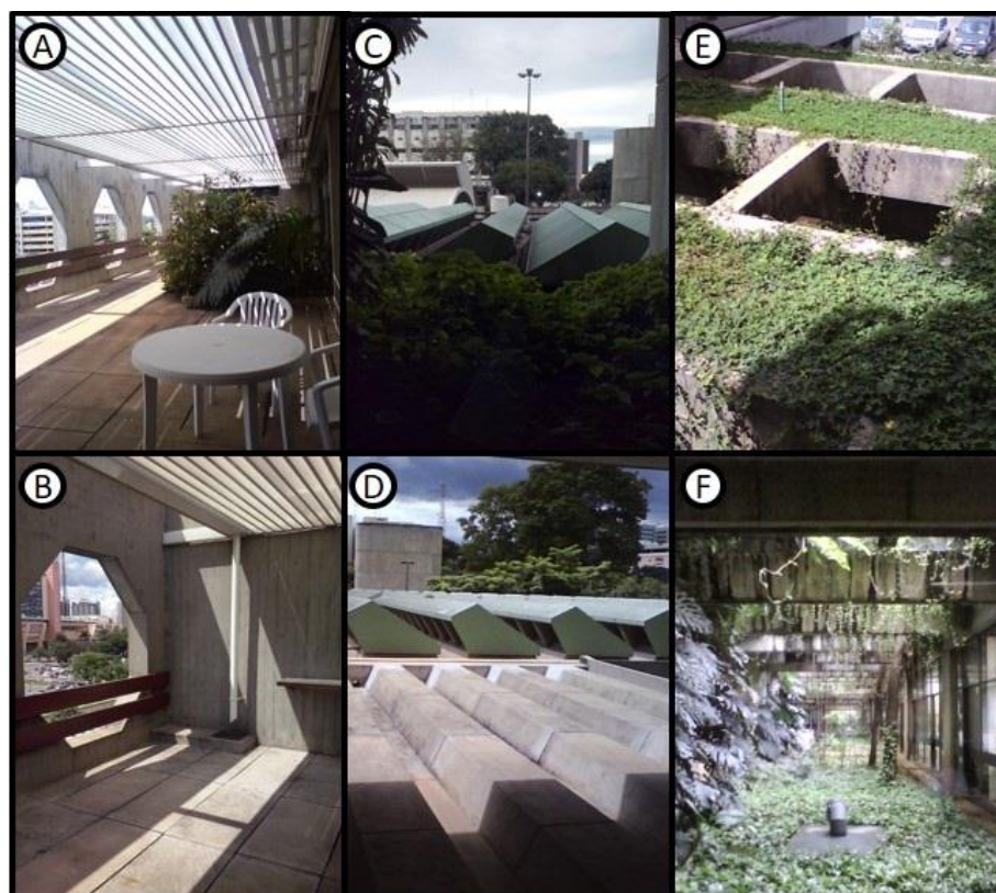
Imagem 23 – Conforto ambiental – em (A) varandas das áreas de internação, (B) varandas das áreas de internação, (C) sheds vistos pelo pavimento térreo, (D) sheds vistos pelo pavimento térreo, (E) jardins internos (vista do térreo) e (F) jardins internos (visto do 1º Subsolo).
