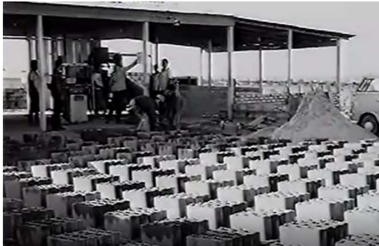
Figura 11. Fabricação de tijolos.
