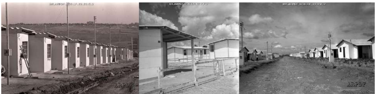
Figura 23. Casas da SHIS em Samambaia, Guará e Gama.
