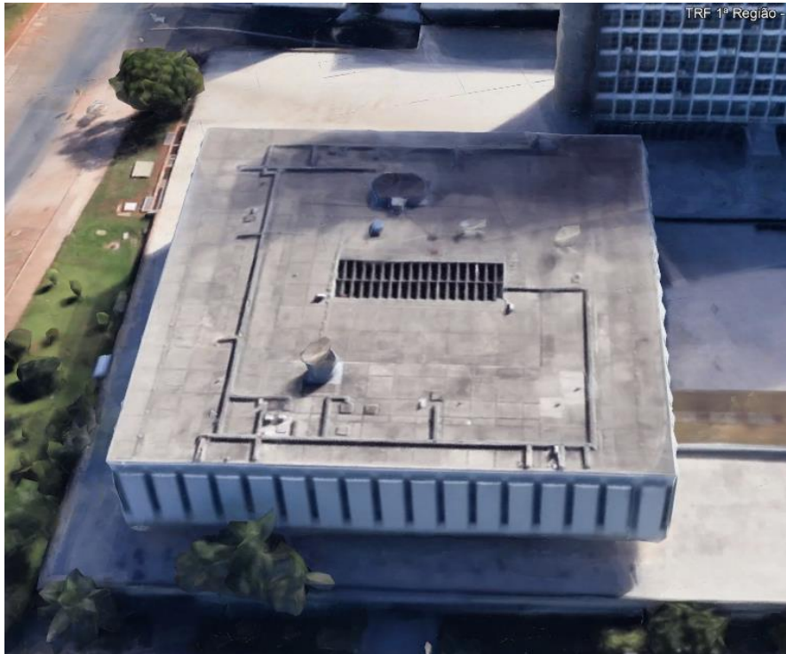
Figura 4-8 - Cobertura em laje impermeabilizada com abertura para iluminação.
