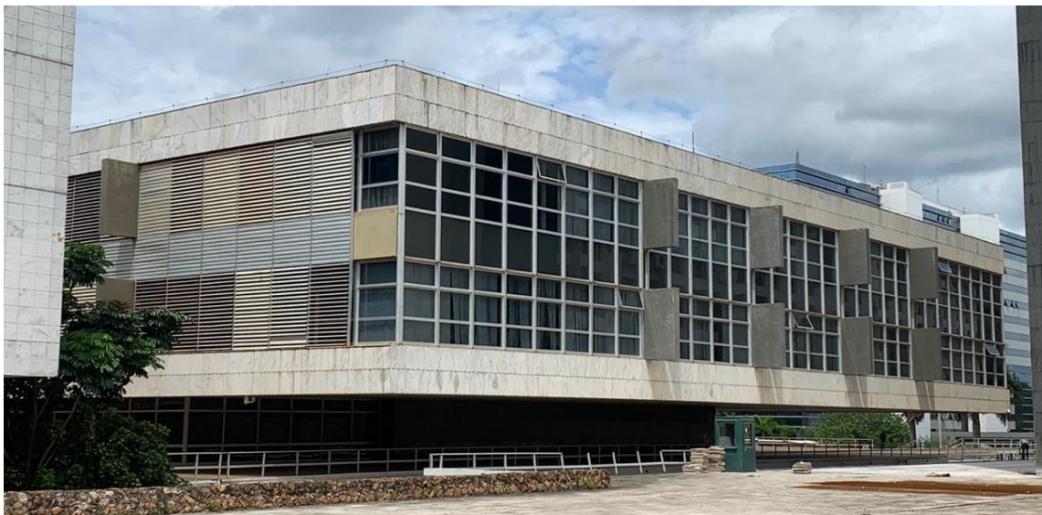
Figura 5-2 - Fachada atual do Edifício Anexo I.
