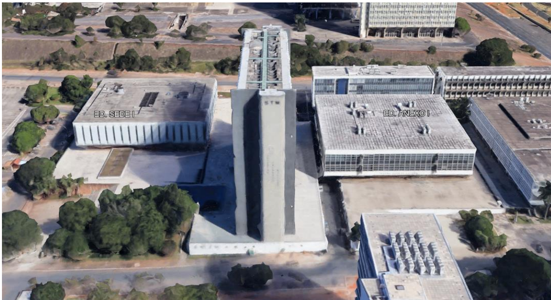
Figura 1-3 – Vista aérea da Praça dos Tribunais Superiores.
