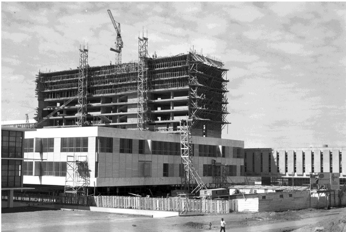
Figura 5-7 - Foto da construção do Ed. Anexo I e atrás do STM - Superior Tribunal Militar em meados de 1968. As duas obras autoria do Arquiteto Nauro Jorge Esteves (s/d).
