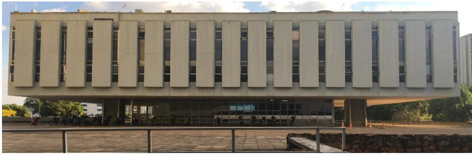
Figura 4-15 - Fachada do Edifício Sede I.
