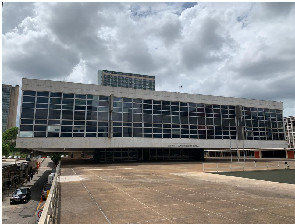
Figura 5-13 - Fachada principal do Edifício Anexo I.
