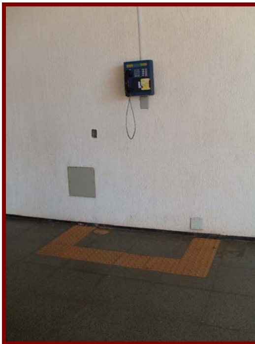
Figura 6: Sinalização de alerta no piso previne que pessoas com deficiência visual se machuquem. Fonte: acervo do autor.
