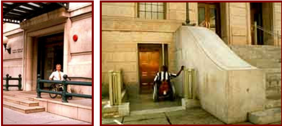
Figura 11: Rampa e elevador próximos à escada, promovendo fácil acesso à edificação histórica. Fonte: NPS, 1993.
