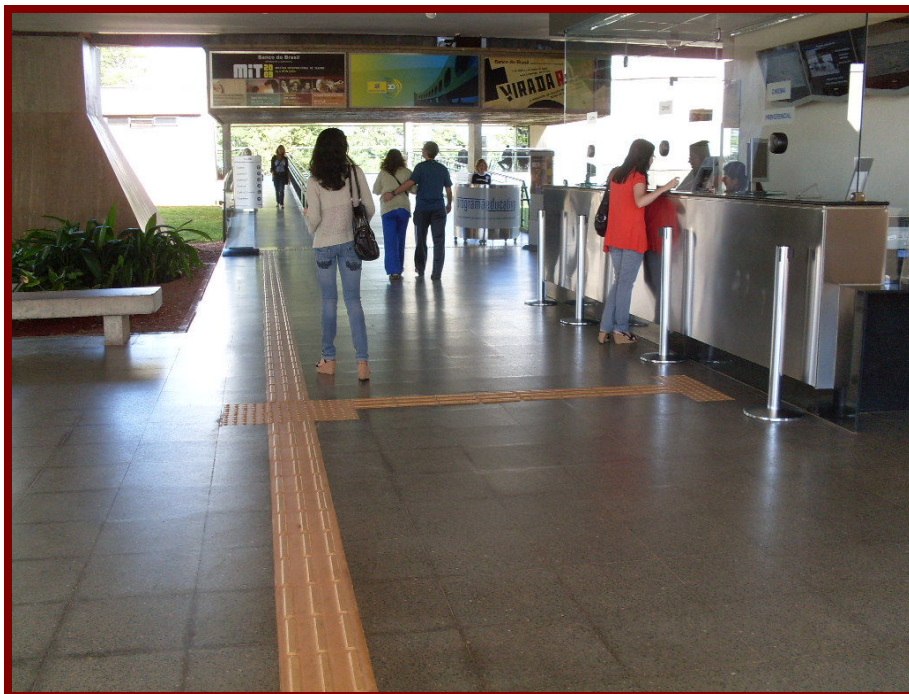
Figura 4: Utilização de piso guia permite a orientação de pessoas com deficiência visual. Fonte: acervo do autor.
