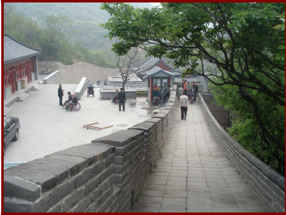
Figura 15: Edificação histórica acessível Fonte: Andrey Schlee
