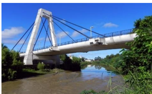
Figura 28. Ponte Estaiada Irineu Bornhausen antes da enchente de 2001 Fonte: Brusque Memória
