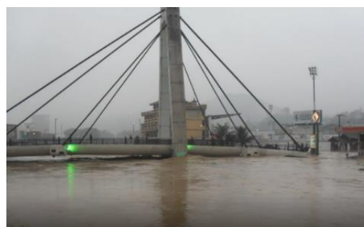
Figura 29. Ponte Estaiada Irineu Bornhausen durante a enchente de 2001 Fonte: Jornal O Município (2011)
