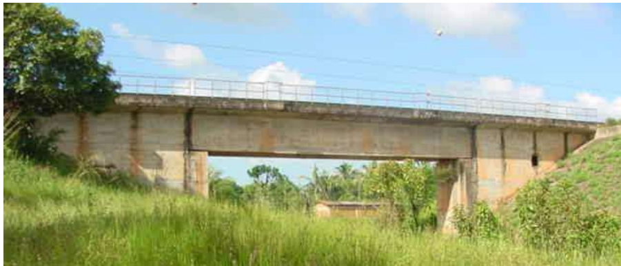
Figura 5.1 – Vista geral do Viaduto sobre CFN 1ª travessia VELOSO (2018).
