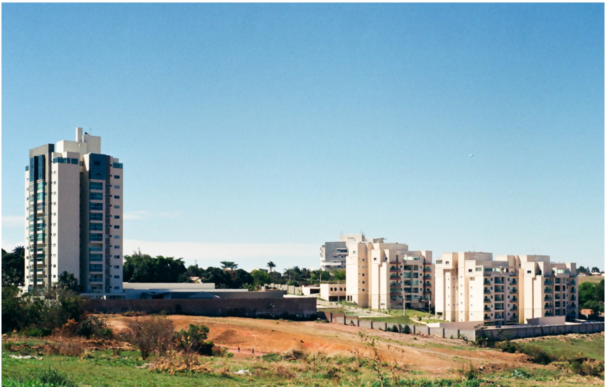
Figura 24: Novos condomínios construídos em Cristalina.
