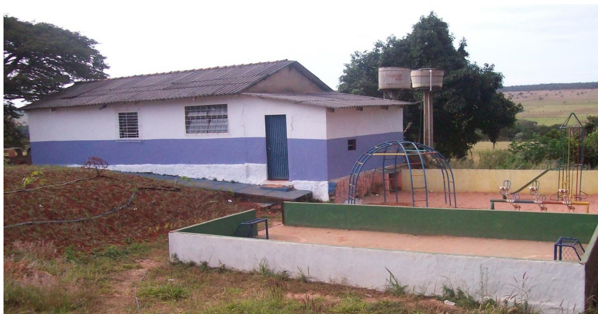
Figura 1- Prédio antigo da Escola Classe Sítio das Araucárias
