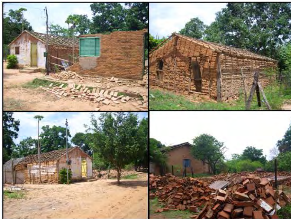
Figura 13: Casas em demolição pelos moradores de Palmatuba. Fonte: O Autor.
