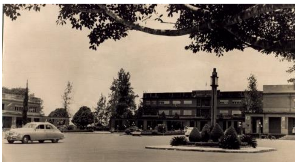
Figuras 83 e 84: Vista parcial da Praça Cívica voltada para o Palácio do governo na década de 1940, demonstrando o espaço demasiadamente aberto e com caixas viárias generosas. Fonte: Acervo MIS|GO
