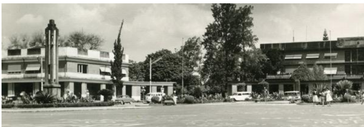
Figura 156: Luminária central no local previsto para o Monumento ao Anhanguera. Foto de Alois Feichtenberger, início da década de 1960. Fonte: Acervo MIS|GO
