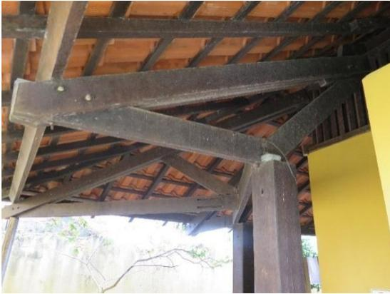
Figura 77 – Detalhe dos encaixes do telhado e do sistema de ventilação. Fonte: Fotografias do autor.
