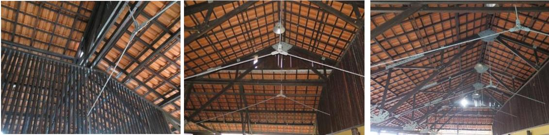
Figura 88, Figura 89 e Figura 90 – Cobertura do salão aberto. Estrutura de madeira reforçada com a utilização de cabos de aço e encaixes em metal. Fonte: Fotografias do autor.
