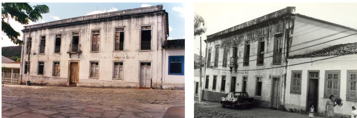
Figura 44: Estado da edificação histórica de abandono.
