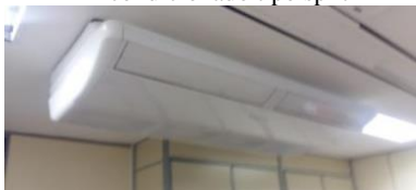
Ar condicionado tipo split
