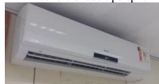
Ar condicionado tipo split
