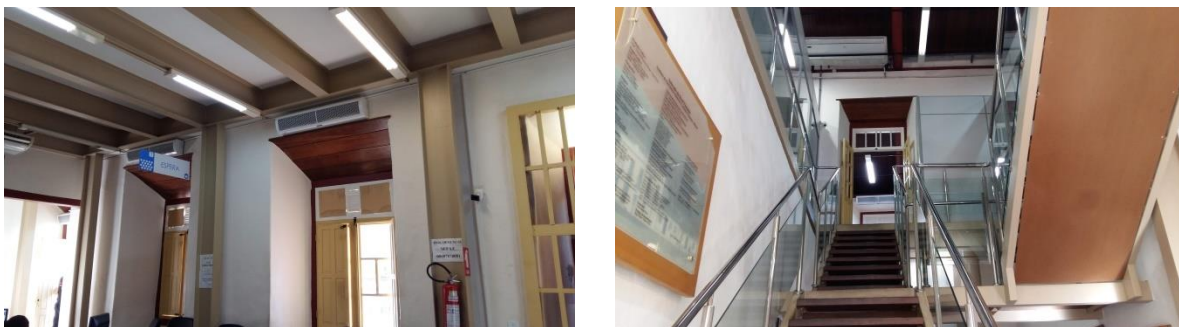
Figura 49: Detalhes da estrutura e escada metálica da Secretaria da Fazenda.
