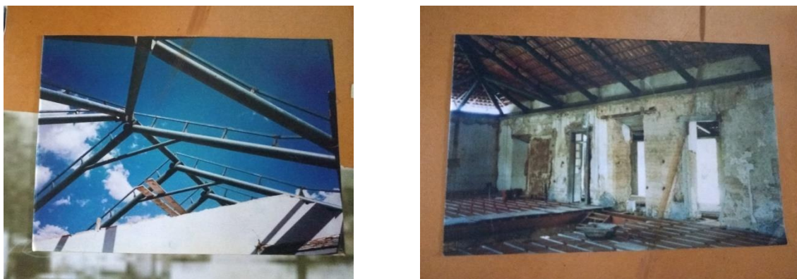
Figura 45: Algumas fotos da obra de adequação na década de 1990 existentes no edifício como registro histórico.
