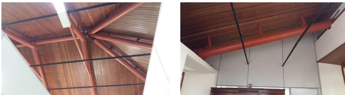
Figura 51: Detalhes da cobertura da Secretaria da Fazenda.
