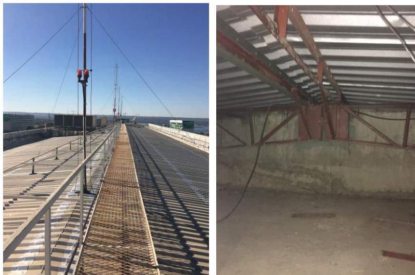
Figura 25 – Cobertura Bloco “E” / Figura 26 – Estrutura de suporte metálico Bloco “E”.
