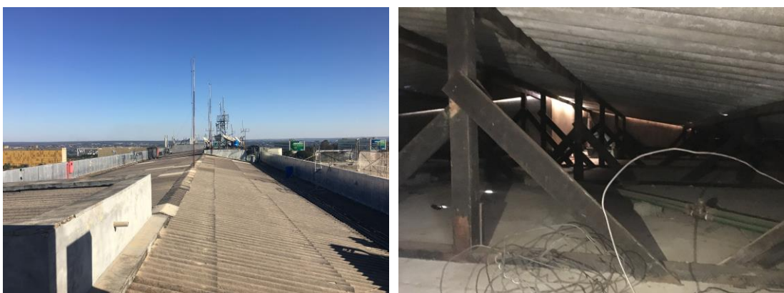
Figura 27– Cobertura Bloco “R” / Figura 28 – Estrutura de suporte de madeira Bloco “R”.
