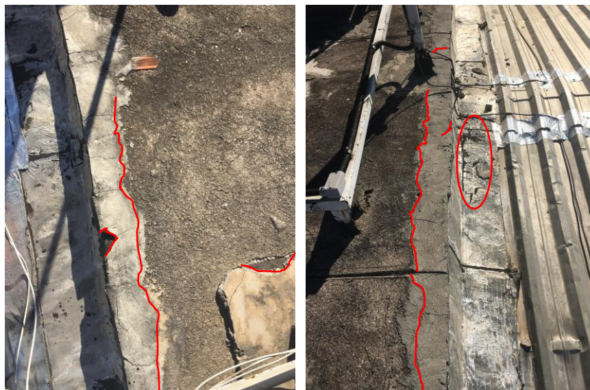
Figura 40 e Figura 41 - Estrutura de suporte - Zona 04 (Autor, 2019).
