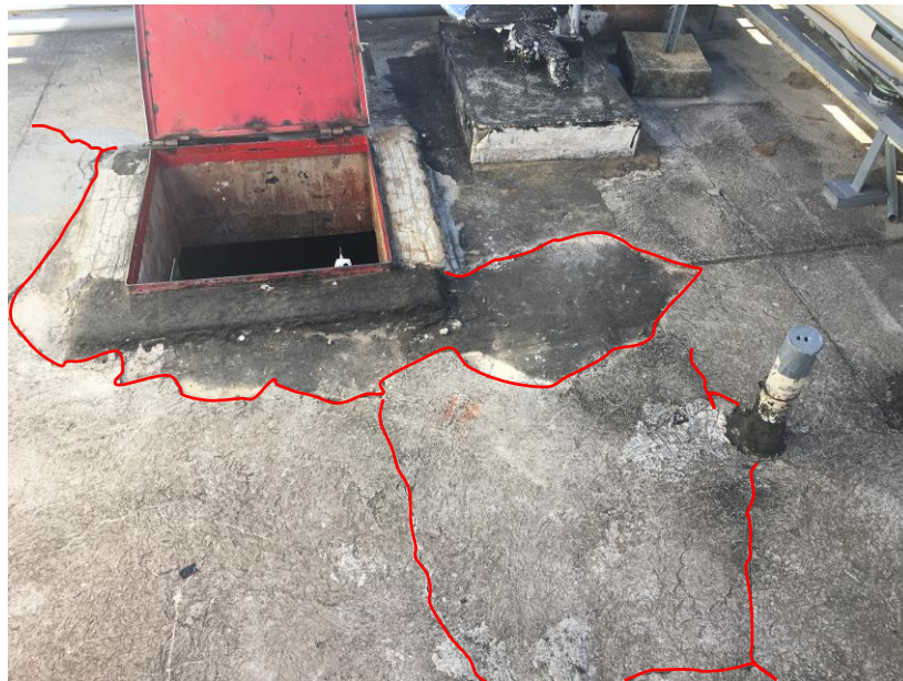
Figura 34 – Estrutura de suporte - Zona 01 (Autor, 2019).
