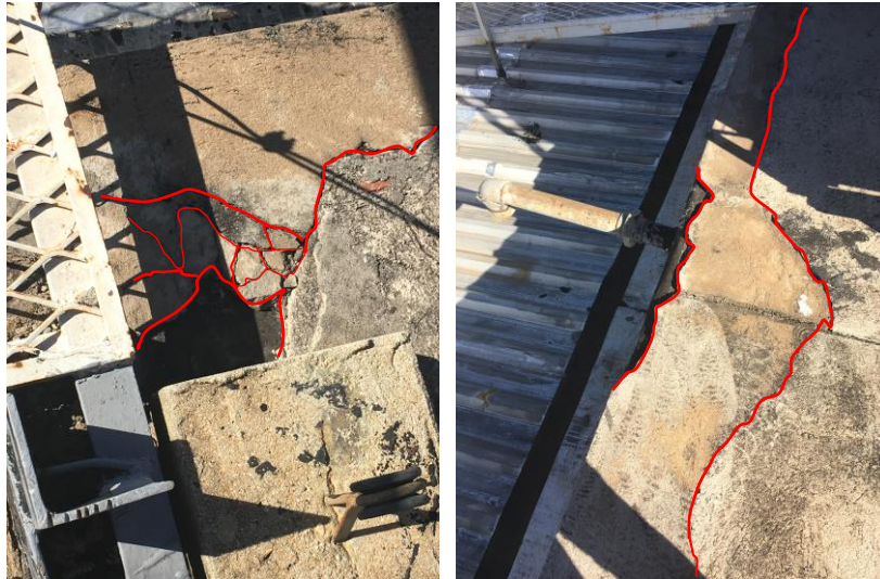
Figura 35 e Figura 36 - Estrutura de suporte - Zona 01 (Autor, 2019).
