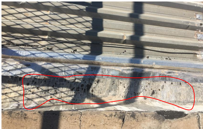
Figura 37 - Estrutura de suporte - Zona 02 (Autor, 2019).
