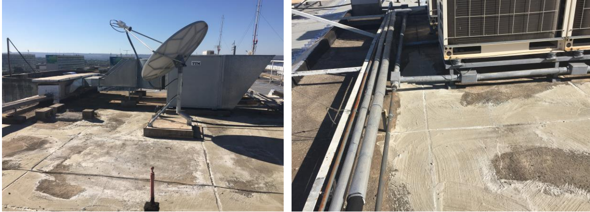
Figura 38 e Figura 39 - Estrutura de suporte - Zona 03 (Autor, 2019).
