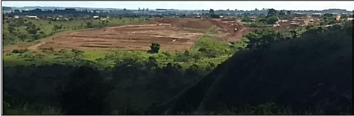
Figura 6.2: Área das 4 bacias de retenção da Sub-bacia L1. Vista do Trecho 2 do SHSN. Declividade entre 10 e 20%.
