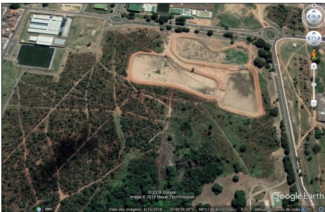
Figura 3.24: Exemplo de lagoas de detenção no Parque Veredinha, em Brazlândia, Distrito Federal. Fonte: Google Earth, 15/06/2018 editada.
