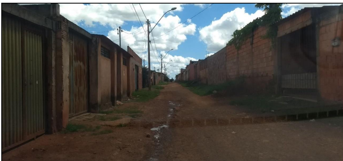
Figura 5.11: Rua do Trecho 3 com dimensões de logradouro público inferiores às normas viárias do DF e, em muitos casos, não haverá separação entre calçada e faixa de rolamento por falta de espaço. Fonte: Acervo do autor (2019).
