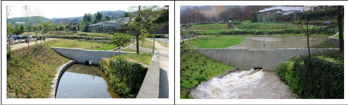
Figura 3.21: bacia de retenção no Ribeira da Costa (cidade de Guimarães-Portugal). Na foto à esquerda, com o nível normal do curso d'água e, à direita, com pico de vazão: o acúmulo a montante do barramento retém inundações a jusante, comum antes da obra. Disponível em: http://www.guimaraesdigital.com
