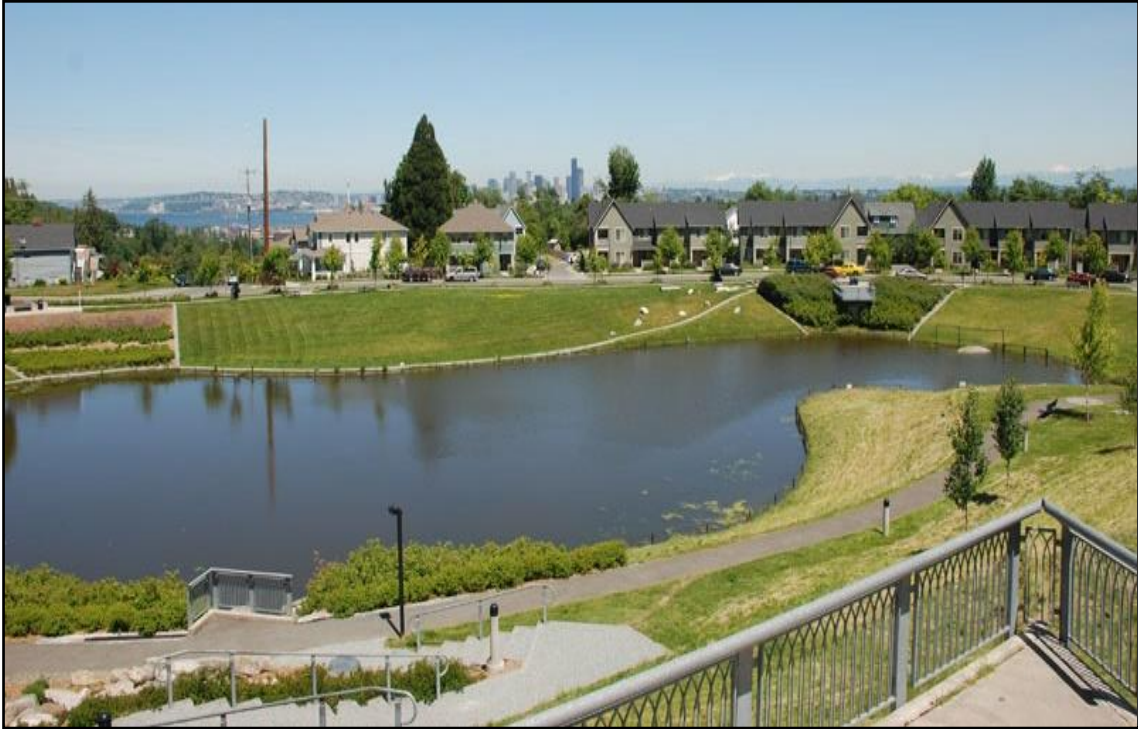
Figura 3.14: Lagoa de retenção em parque no bairro High Point da zona oeste de Seattle/WA. Disponível em: https://highpointseattle.com/about-high-point/natural-drainage-system/
