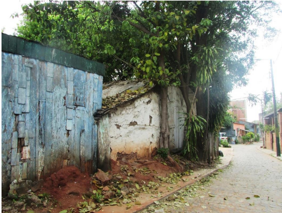
Figura 19: Casa de madeira e casa de adobe em San Jerónimo
