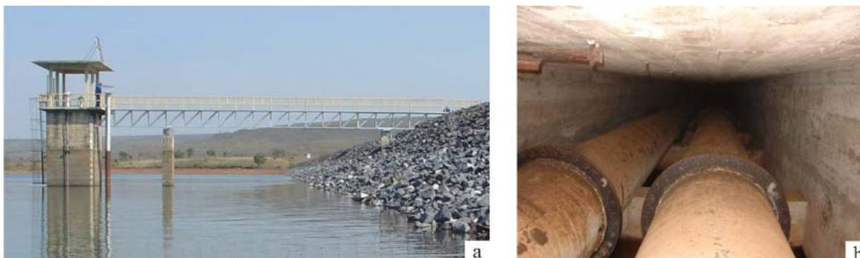
**Figura 14 – Estrutura de captação e adução da barragem de Santa Maria: (a) torre da tomada d'água; (b) interior da galeria sob a barragem-jusante para montante. FONTE: Perini (2009).**
