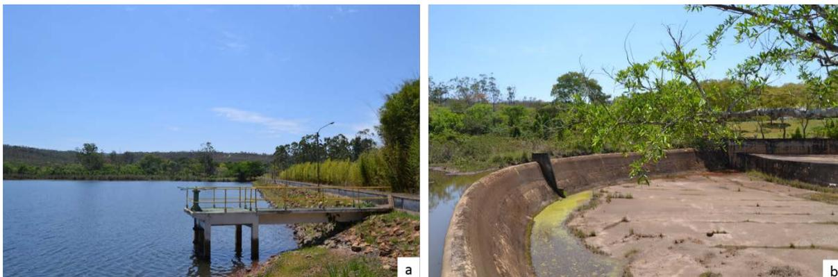
**Figura 17 – Barragem Torto: (a) reservatório, tomada d'água e crista do coroamento; (b) vertedouro soleira livre perfil Creager em leque. FONTE: da autora.**
