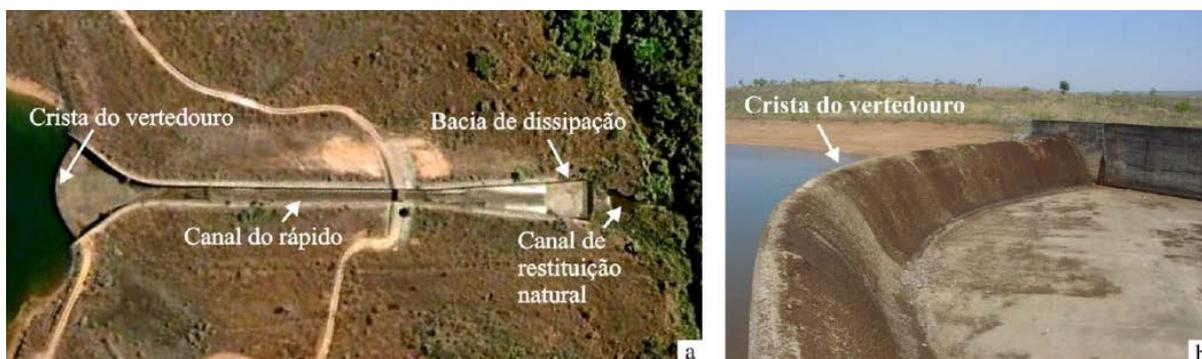
**Figura 13 – Estrutura responsável pela extravasão das vazões excedentes da barragem de Santa Maria: (a) conjunto: vertedouro, rápido e bacia de dissipação; (b) vertedouro do tipo soleira livre, em leque com perfil do tipo Creager. FONTE: Perini (2009).**
