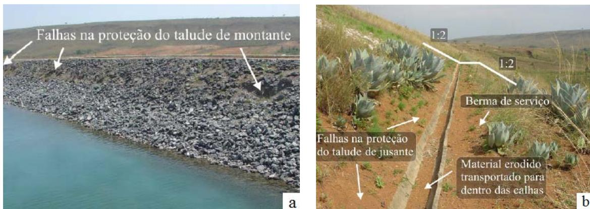
**Figura 56 – Paramentos da barragem de Santa Maria: (a) Talude de montante: falhas na proteção com o surgimento de buracos de erosão. (b) Talude de jusante: falhas na proteção e indícios de erosão superficial. FONTE: adaptado de Perini (2009).**
