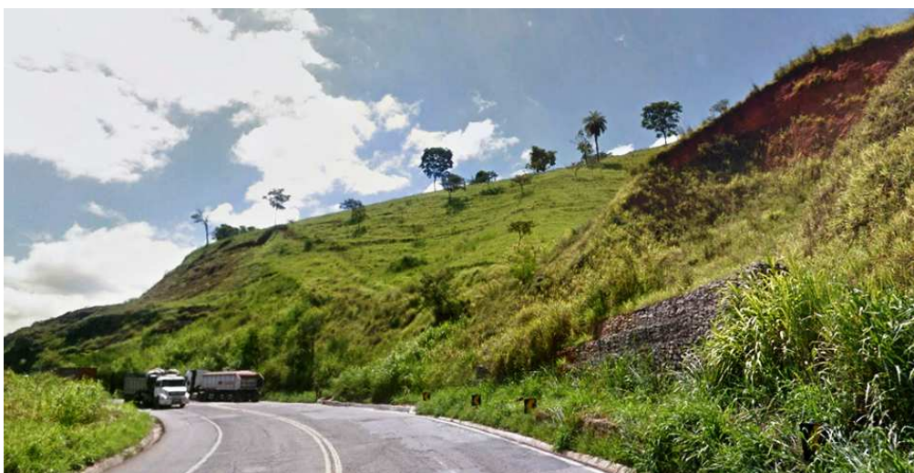
Figura 5.4: Seção transversal da zona 46 do trecho 6 da BR-381 (Fonte: Google street view , 2019)
