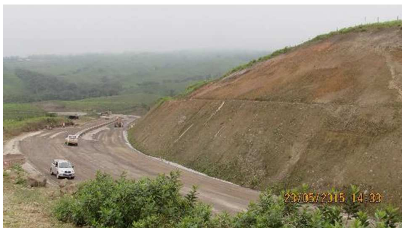
Figura 5.12: Exemplo de bermas na rodovia Sifón-La Abundancia . Fonte: Ocampo (2016)
