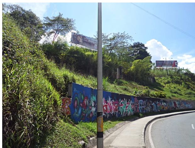
Figura 5.6: Exemplo de muro de concreto na rodovia Las Palmas . Fonte: Moreno (2015)
