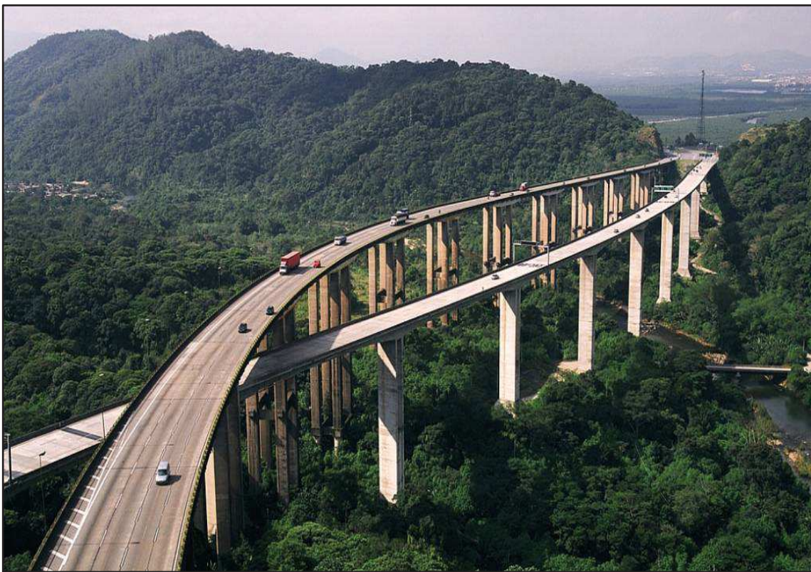
Figura 42 – Viadutos da rodovia dos imigrantes a cortar área de Mata Atlântica. Foto: Ecovias imigrantes; 2013
