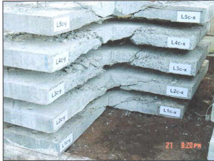
Figura 4.39 – Superfícies de ruptura das lajes “c”
