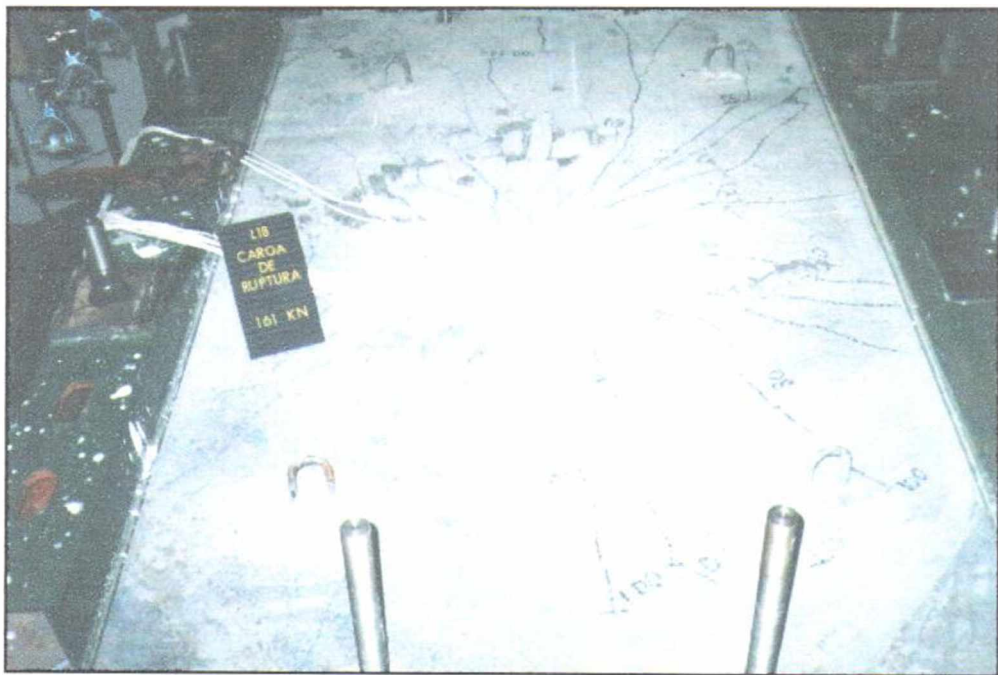
Figura 4.7 – Mapa de fissuração da laje L1b
