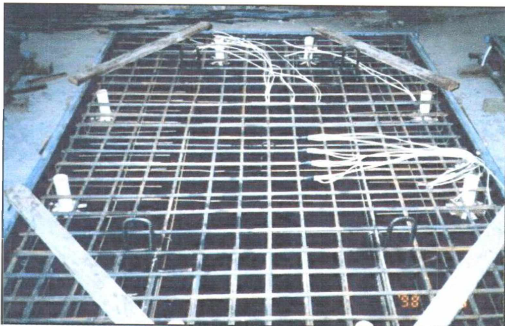
Figura 3.3b – Armadura superior posicionada nas formas
