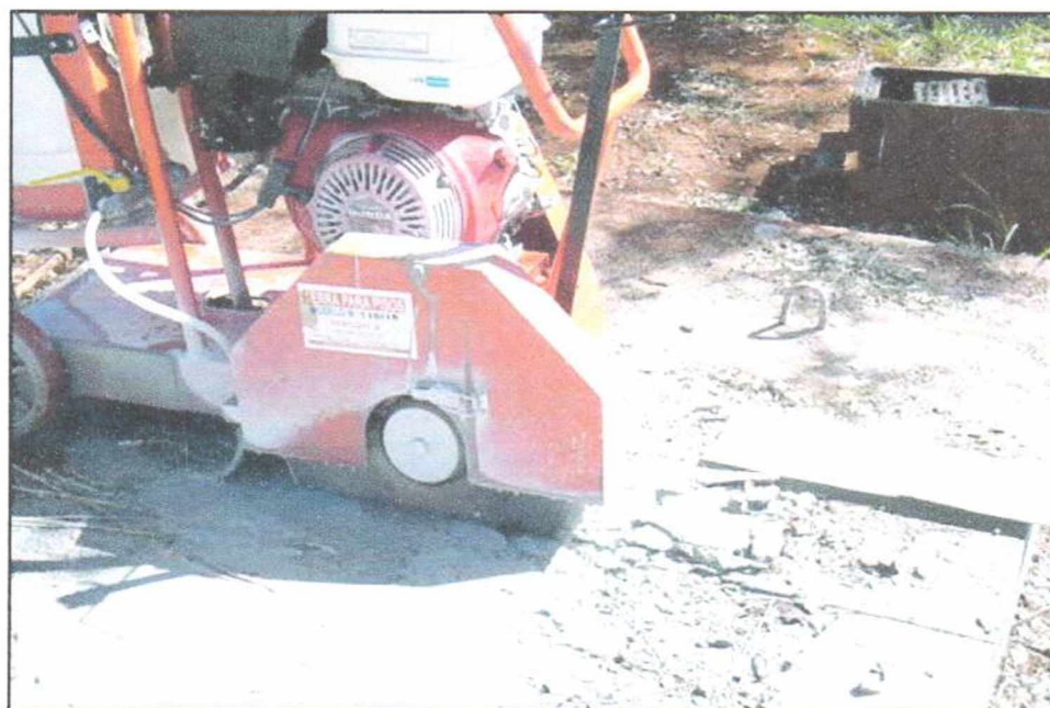
Figura 4.22 – Equipamento utilizado no corte das lajes
