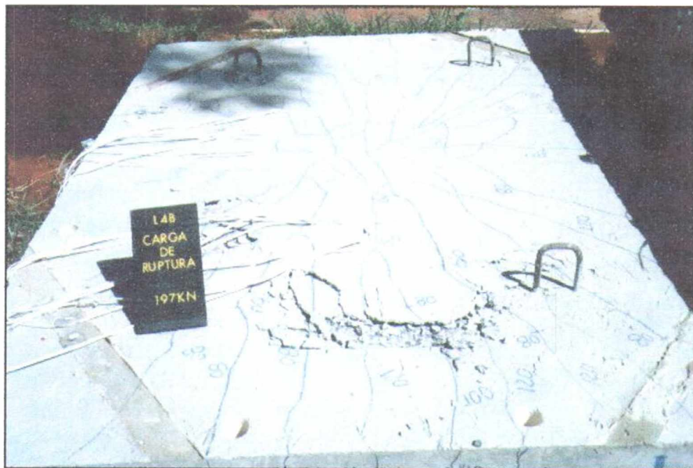
Figura 4.16 – Mapa de fissuração da laje L4b
