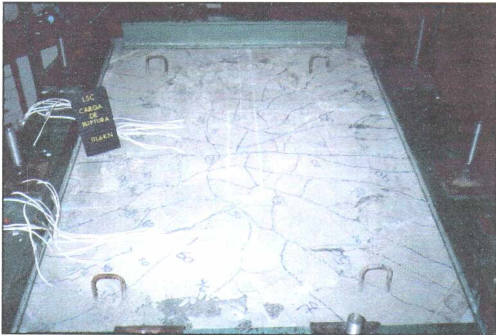
Figura 4.20 – Mapa de fissuração da laje L5c
