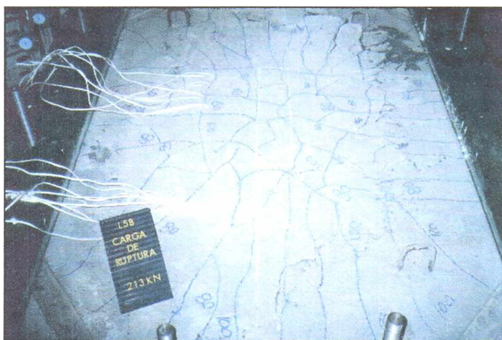
Figura 4.19 – Mapa de fissuração da laje L5b
