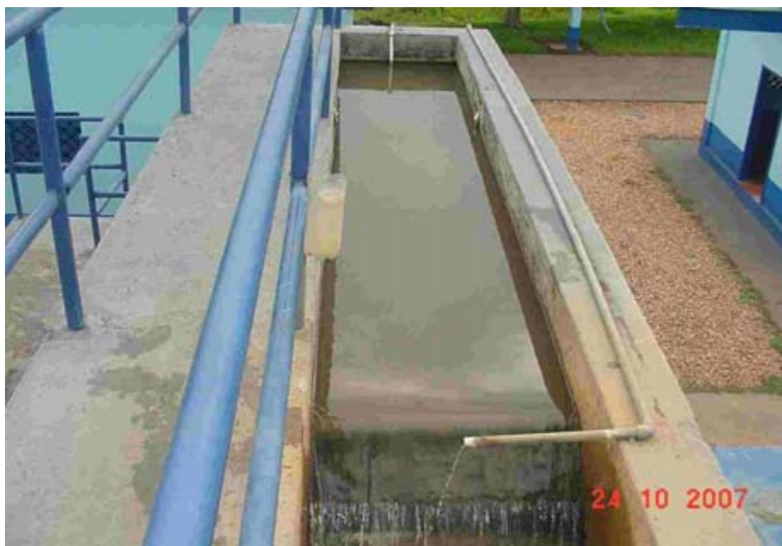
Foto 4 – Recepção de água bruta e adição de coagulante. (foto: Vonivaldo G. Leão)
