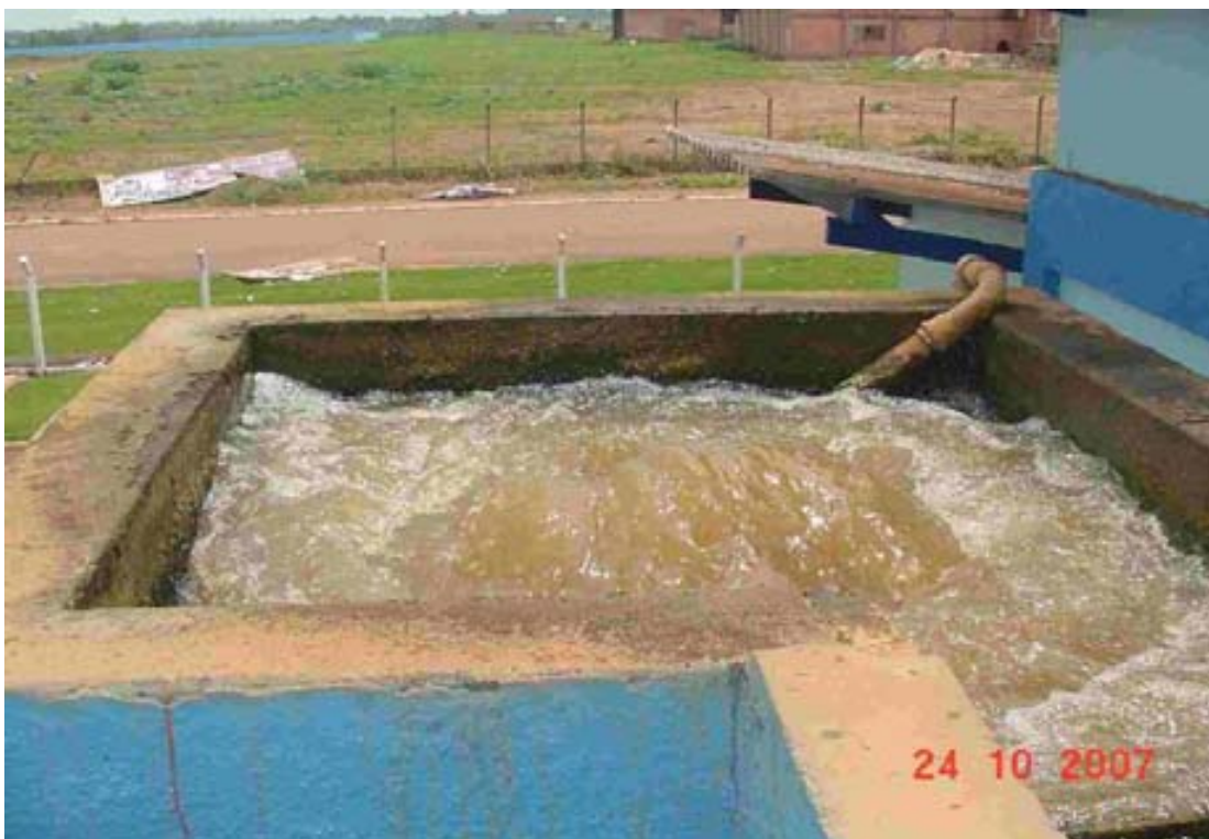
Foto 6 – Recepção de água bruta. (foto: Vonivaldo G. Leão)
