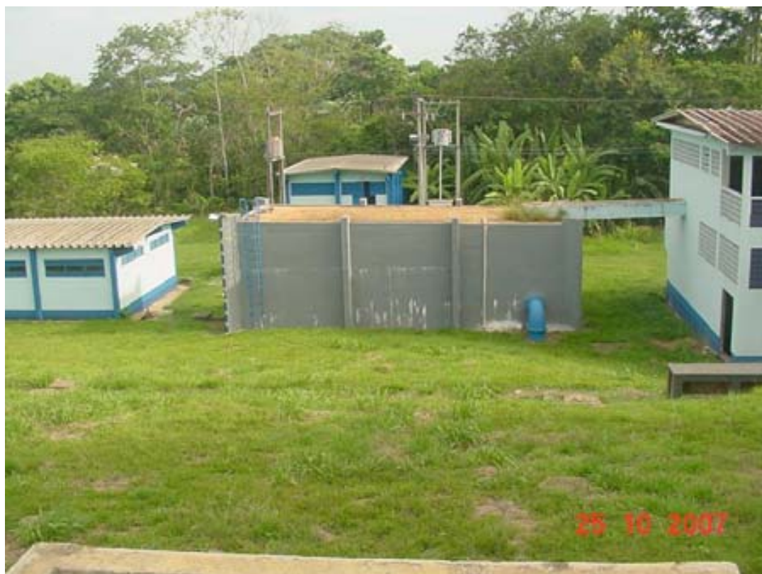
Foto 14 – Sistema de Filtração. (foto: Vonivaldo G. Leão)
