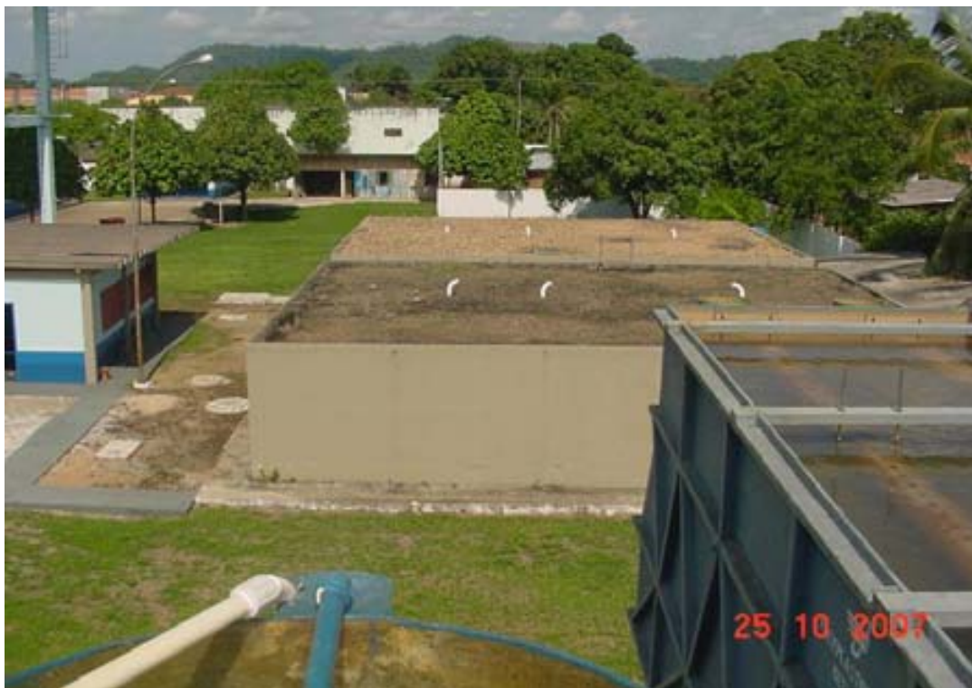
Foto 11 – Sistema de Filtração. (foto: Vonivaldo G. Leão)
