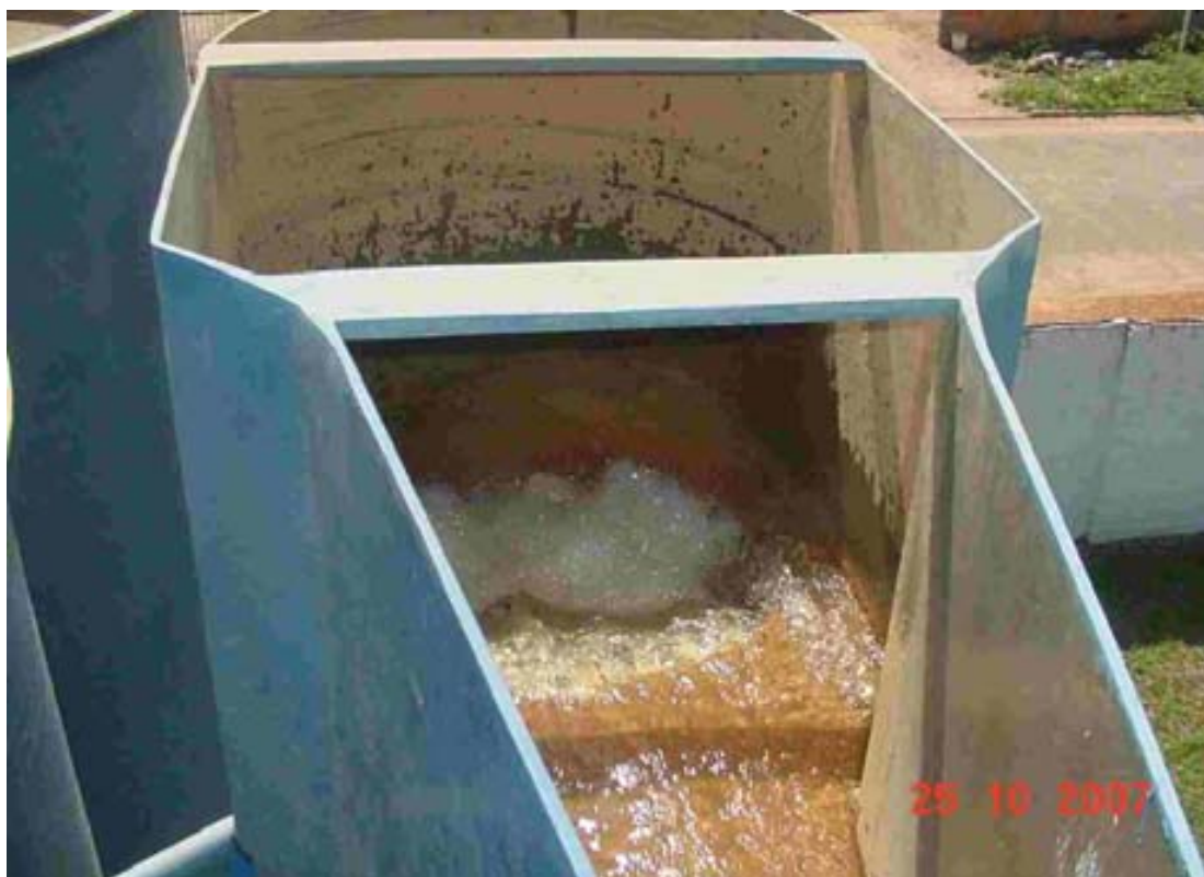
Foto 9 – Recepção de água bruta. (foto: Vonivaldo G. Leão)
