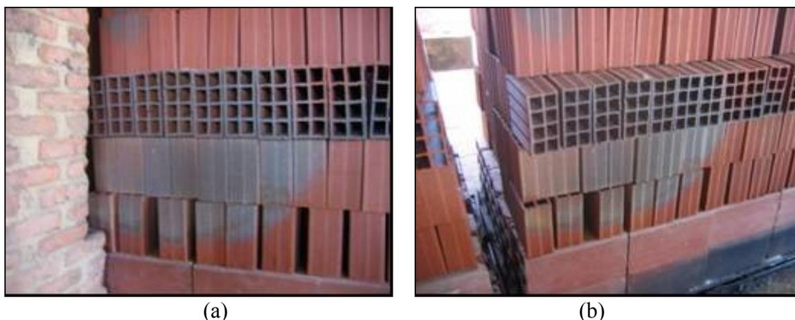
Figura 5.27 – Blocos cerâmicos requeimados na fase de queima a partir da lenha de eucalipto.
