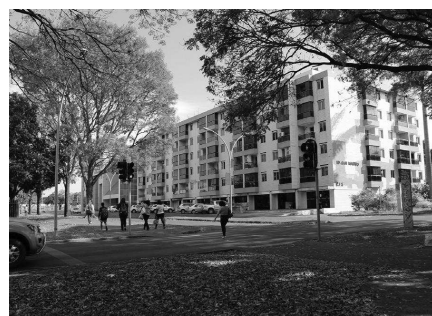
FIGURA 3.43 Edifício San Marino – SEUPS 707/907 (2016). Autoria própria. Acervo da pesquisa.
