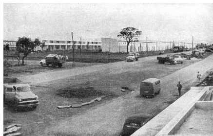
FIGURA 3.6 Casas “duplex” vistas a partir de uma loja das quadras 500. Fonte: Revista Brasília, nov. 1959, n. 35, p. 6.
