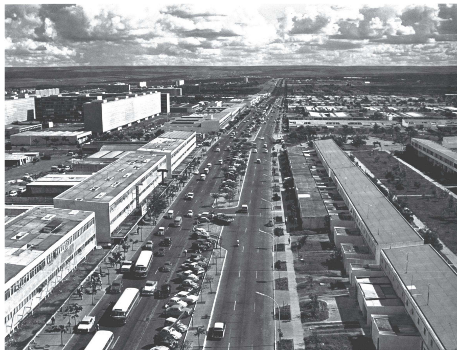
FIGURA 0.5 Vista aérea da W3 Sul, 1968. Fonte GDF, 2002.
