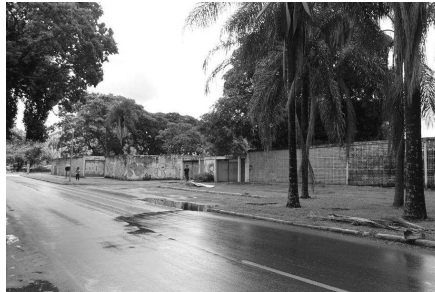
FIGURA 3.29 – Edificações nas EQS 712/912. Vista da W4. Autoria própria. Acervo da pesquisa.
