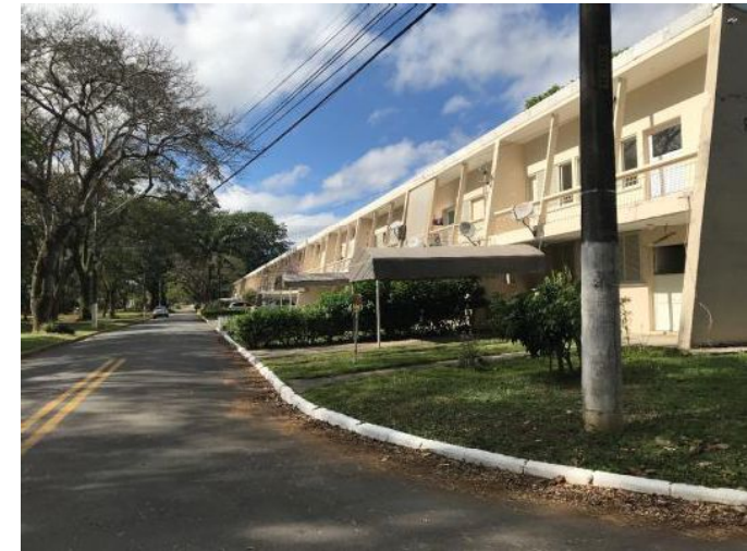
Figura 40 - H-10 em 2018, com as instalações de coberturas de garagem removíveis autorizadas pela PASJ.
