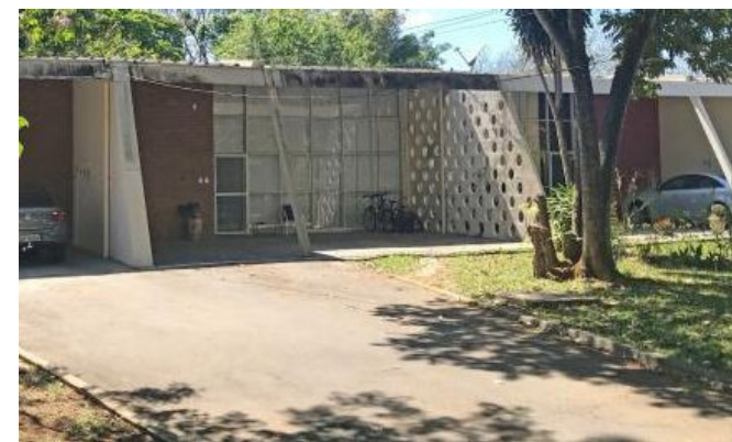
Figura 61 - Fachada frontal em 2018, mantendo as características originais. Fonte: Foto do autor, 2018.
