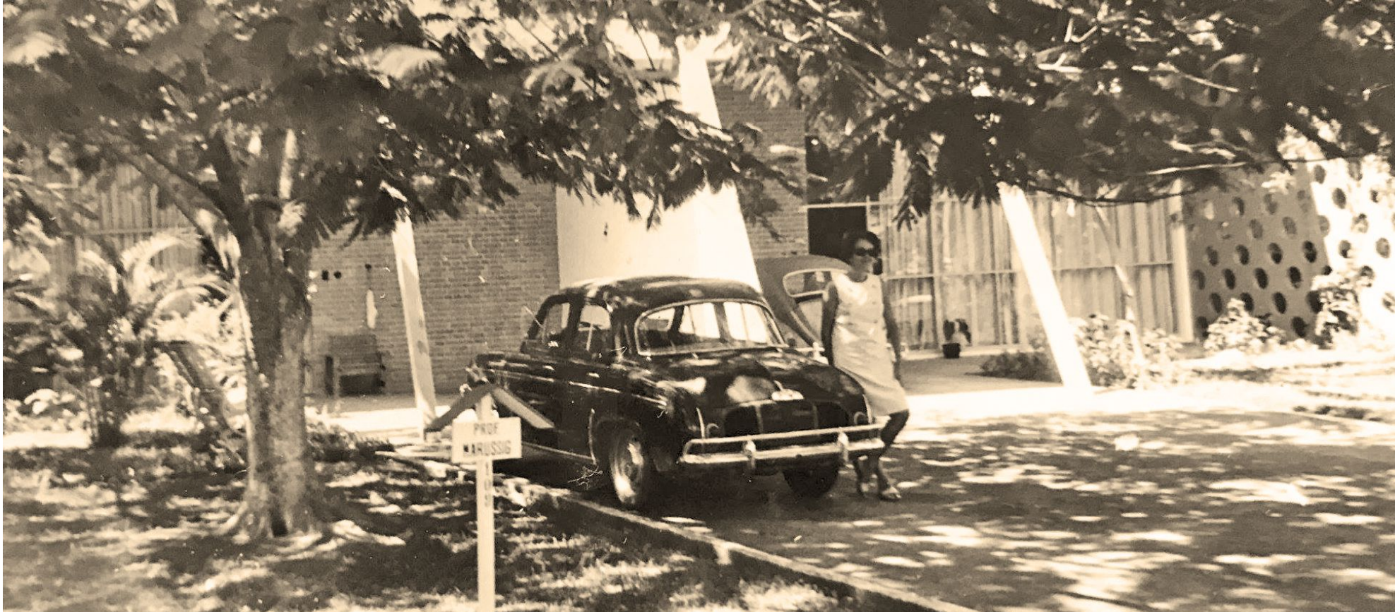
Figura 58 - Fachada frontal de duas unidades do H-20 em 1960. Fonte: Acervo Pessoal José Antônio Marussig.
