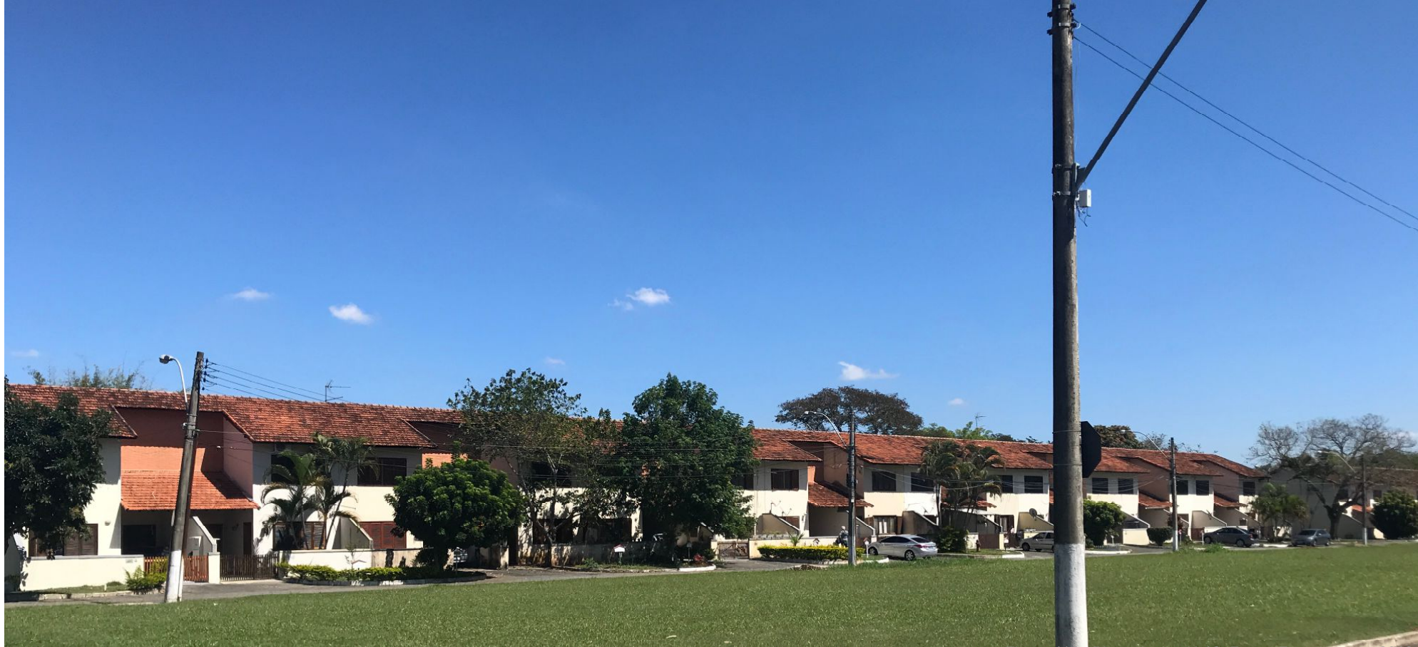
Figura 114 - Bloco do tipo H-12. Fonte: Foto do autor, 2018.
