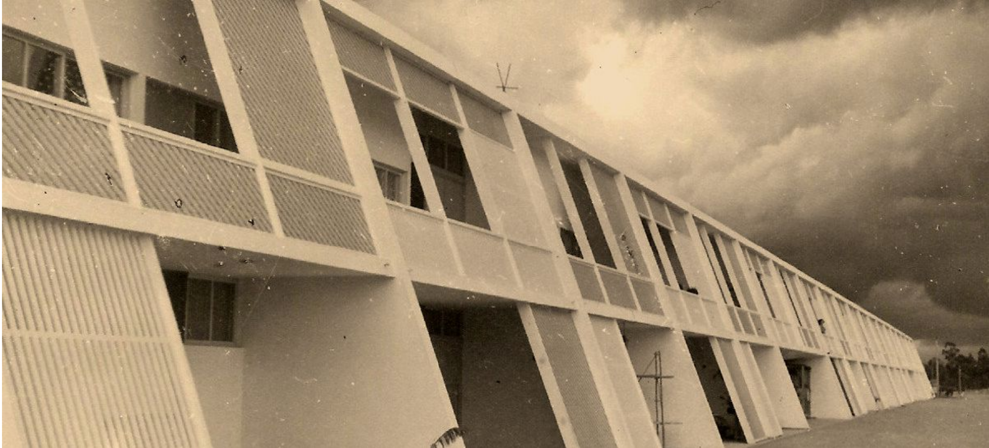
Figura 47 - H-18 em 1952 com detalhe das gelosias e sem os jardins da fachada frontal. Fonte: Arquivo pessoal Michael Swoboda.
