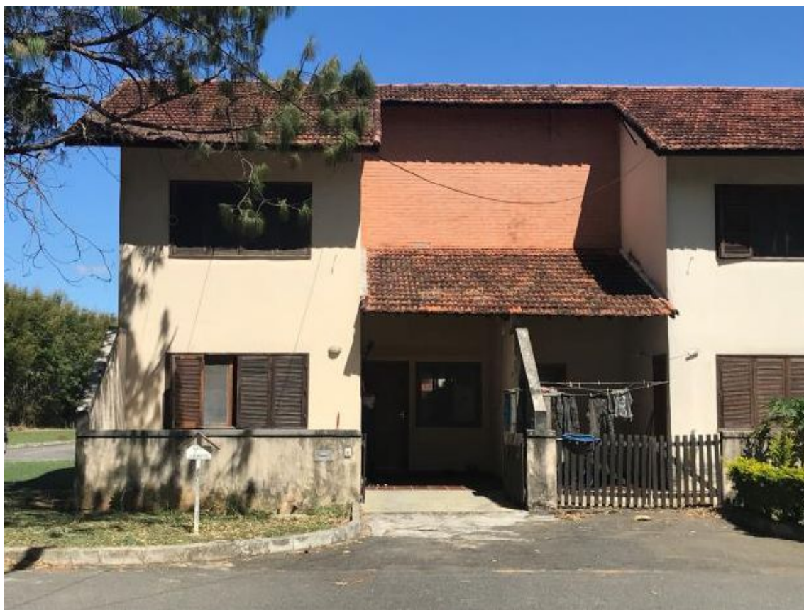
Figura 115 - Fachada frontal de unidades do H-12. Fonte: Foto do autor, 2018.
