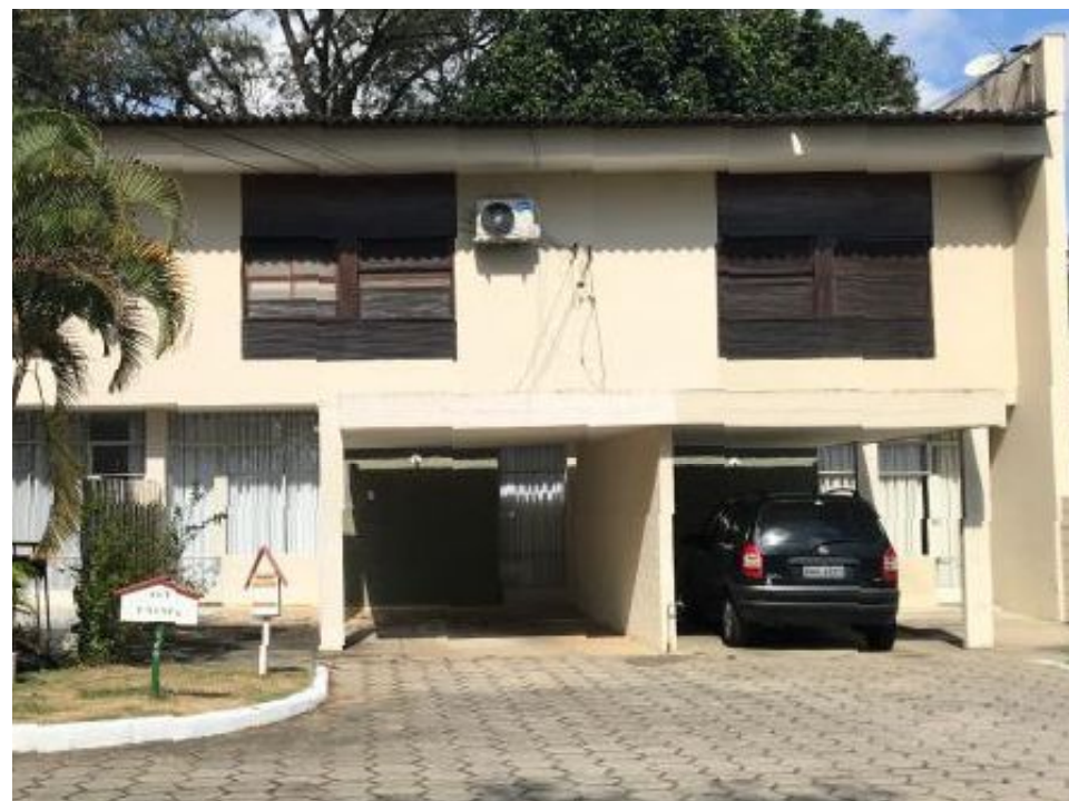
Figura 95 - Fachada de unidade do H-30-A, de 1967. Condições em 2018. Fonte: Foto do autor, 2018.
