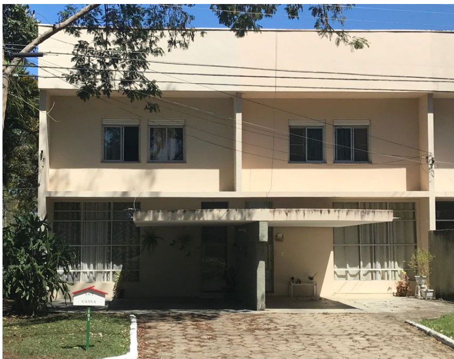
Figura 96 - Fachada dos H-30-B, C e E, de 1982. Fonte: Foto do autor, 2018.
