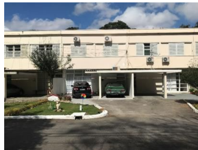
Figura 85 - Fachada frontal em 2018 de PNR H-26-A, detalhe para pavimentação de jardim para segunda vaga de veículo. Fonte: Foto do autor, 2018.
