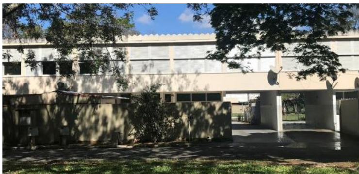
Figura 56 - Fachada posterior do H-19-B em 2018. Fonte: Autor, 2018
