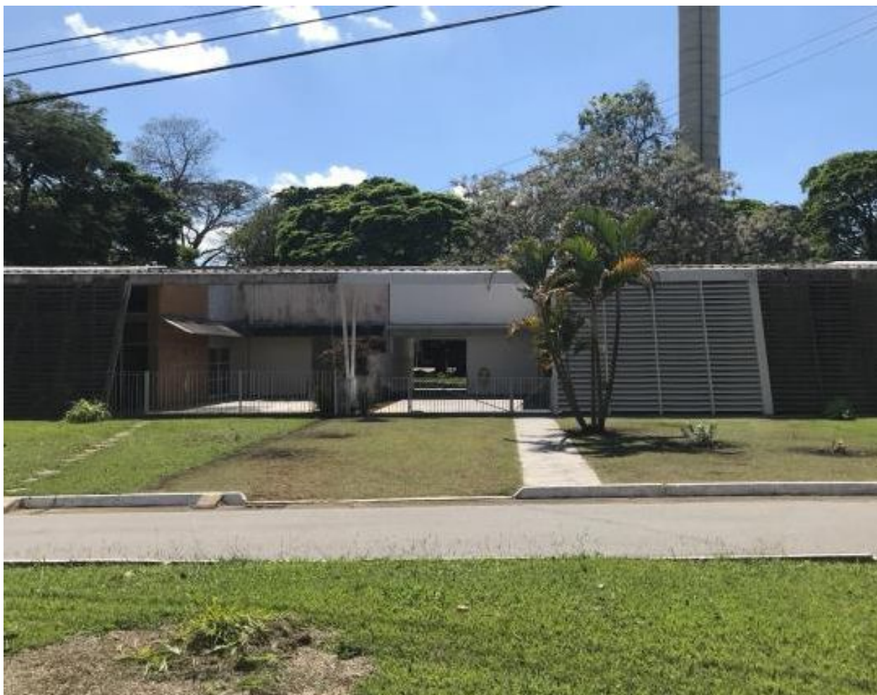
Figura 57 - Fachada frontal H-19, com detalhe do meio-fio rebaixado para acesso de veículos pelo jardim. Fonte: Autor, 2018.
