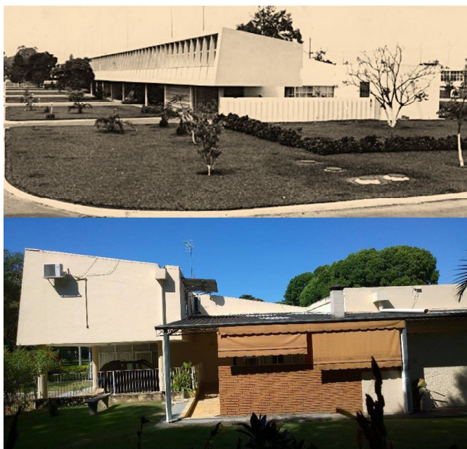
Figura 44 - Residência da extremidade do H-17-C. Fachada lateral em 1960 e em 2019. Fonte; MORI, 2013 p.172 e foto do autor, 2019.
