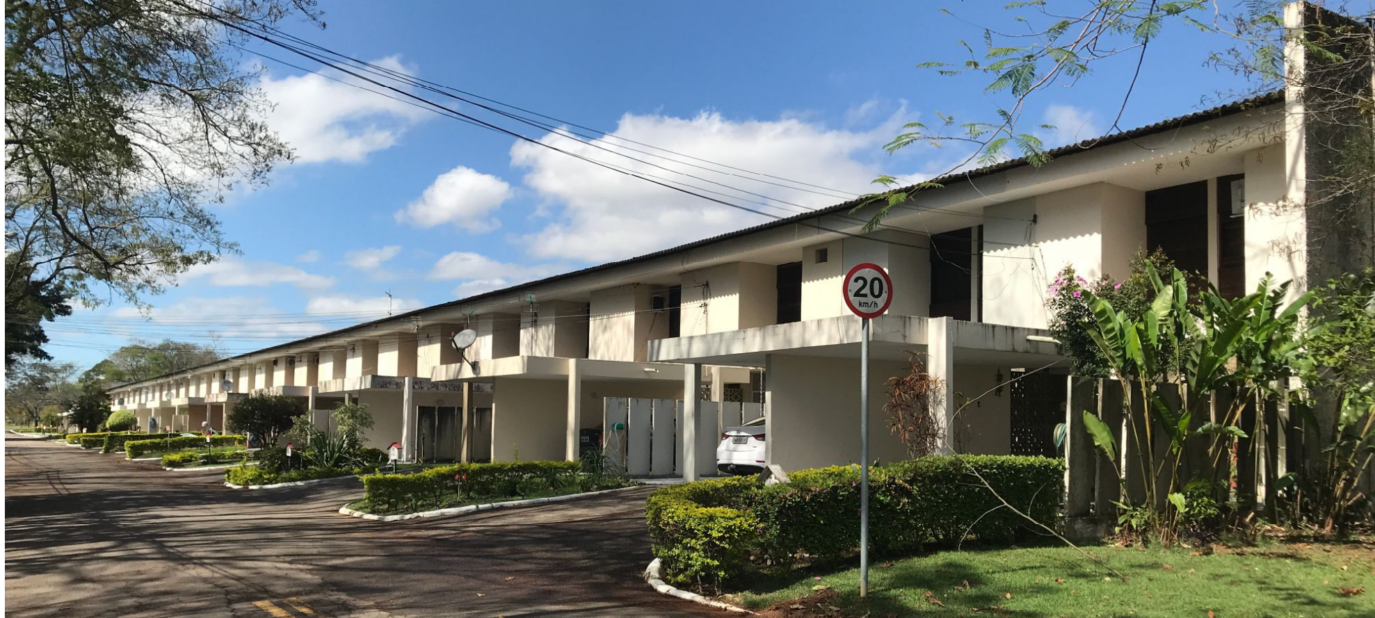
Figura 99 - Fachada de unidades do H-32-A. Fonte: Foto do autor, 2018.
