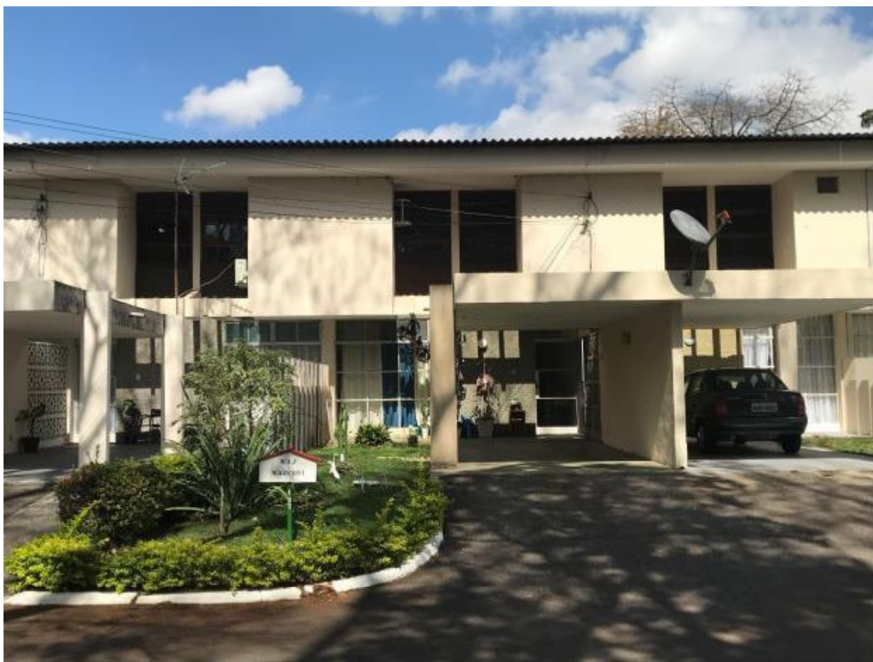
Figura 101 - Fachada de unidades do H-32-A. Fonte: Foto do autor, 2018.
