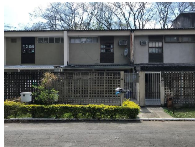
Figura 102 - Fachada posterior do H-32-A. Fonte: Foto do autor, 2018.
