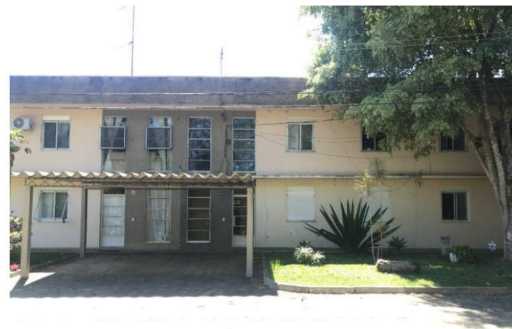
Figura 118 - Fachada frontal de unidade tipo H-11. Fonte: Autor, 2018
